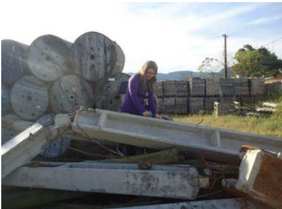
Figura 2 - Poste em concreto após colisão de transito (Fonte: Lorenzi, 2015)
