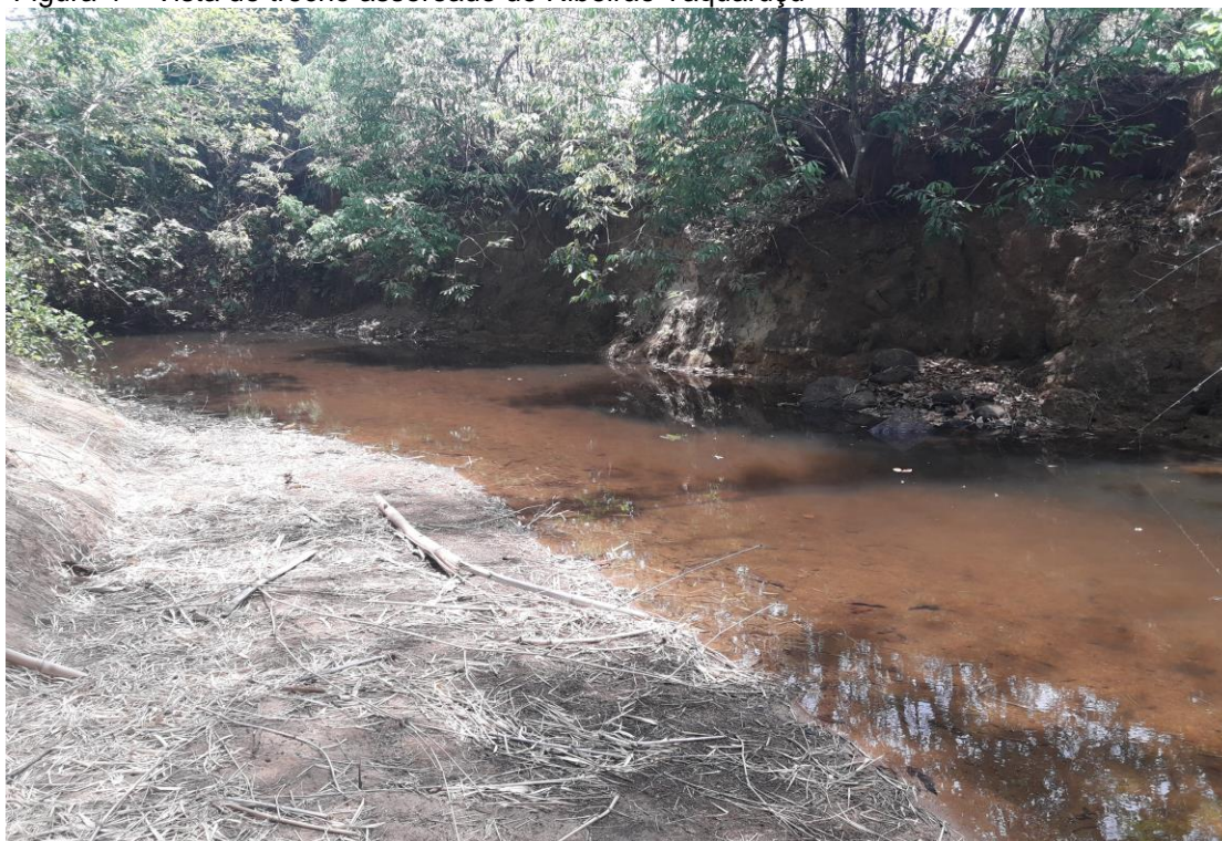
Figura 4 – Vista de trecho assoreado do Ribeirão Taquaruçu
