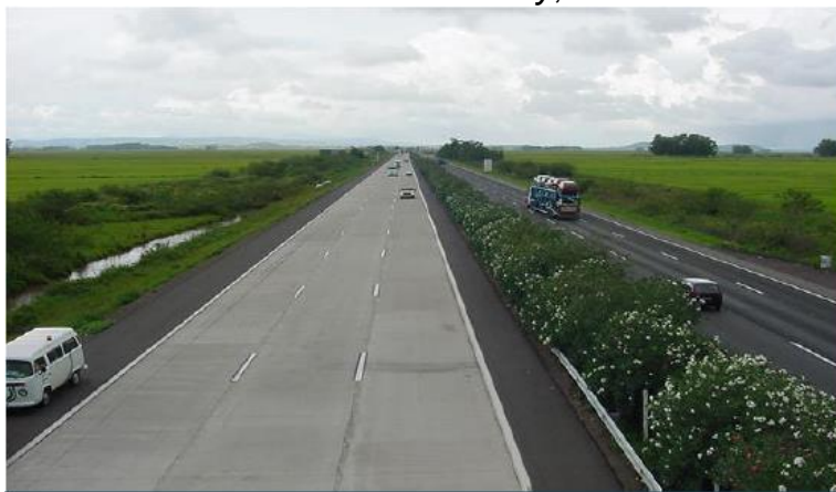
Figura 48: Trecho da rodovia BR – 290 Free Way , restaurada com o Whitetopping .
