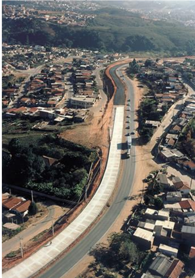
Figura 44: Reabilitação do pavimento da rodovia SP-103/79.
