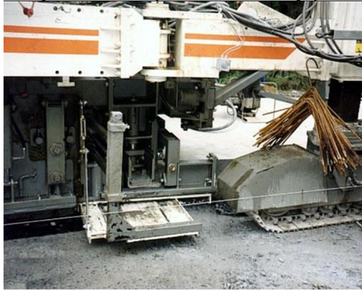
Figura 30: Colocação das barras de ligação.
