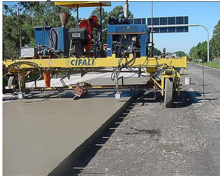
Figura 36: Texturização mecânica.
