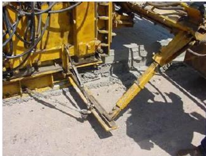
Figura 31: Inserção lateral das barras de ligação
