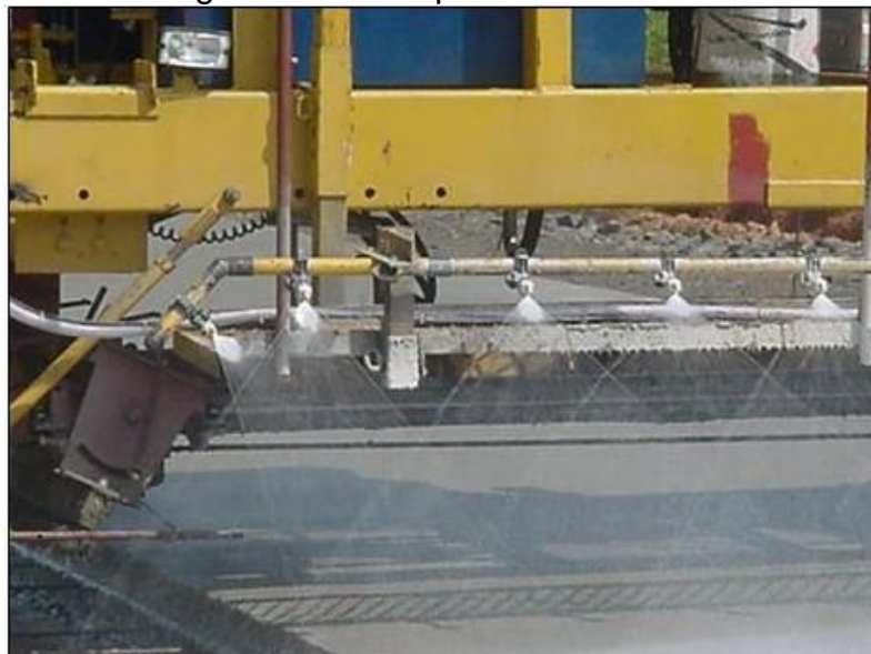
Figura 39: Cura química mecânica.
