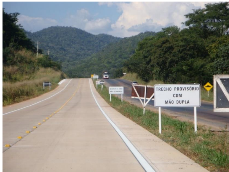
Figura 52: Rodovia BR 163 na altura da Serra de São Vicente e Cuiabá-MT.
