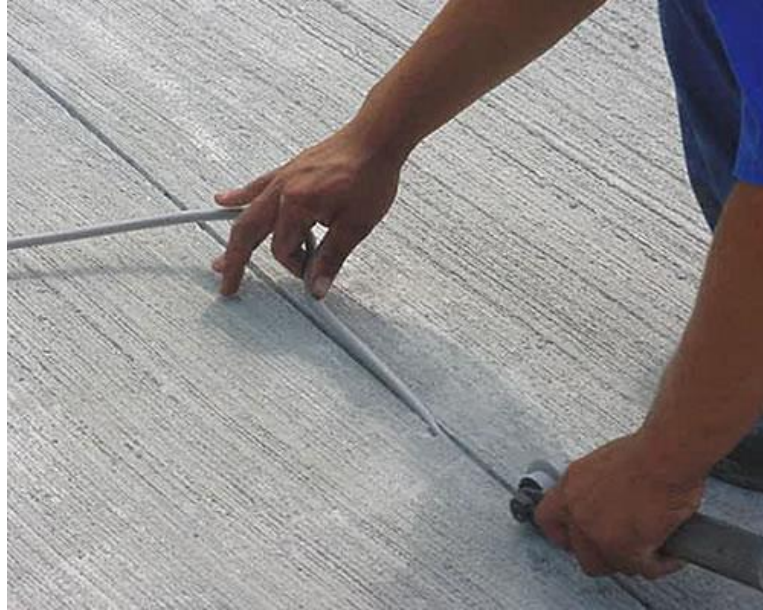
Figura 42: Selagem das juntas – colocação do material de enchimento.
