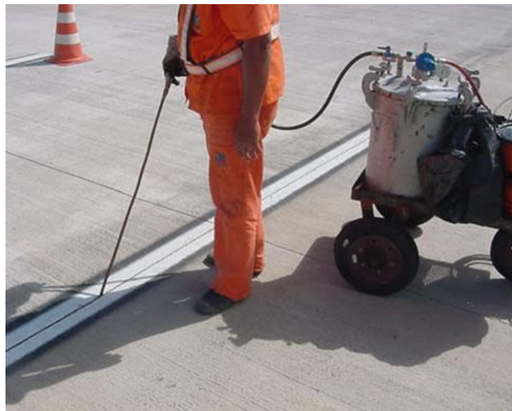
Figura 43: Selagem das juntas.
