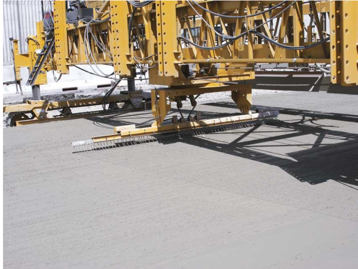
Figura 37: Texturização mecânica.
