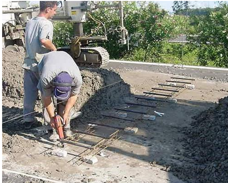
Figura 27: Colocação das barras de transferências de carga.
