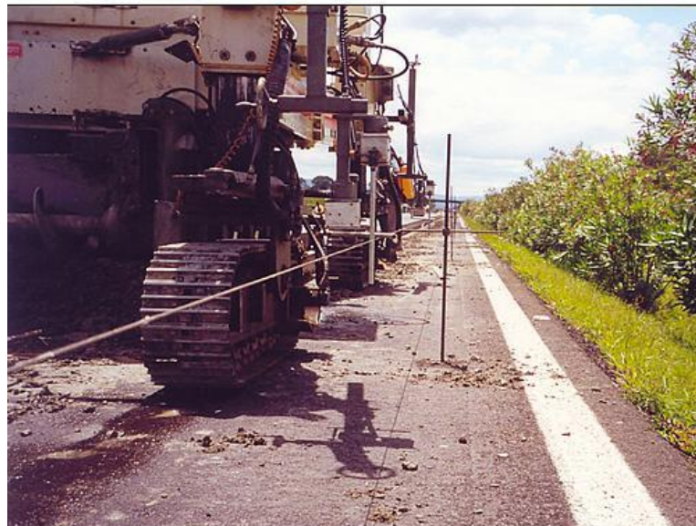
Figura 23: Instalação do sistema de referência.
