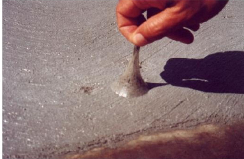
Figura 40: Cura química – Película protetora.
