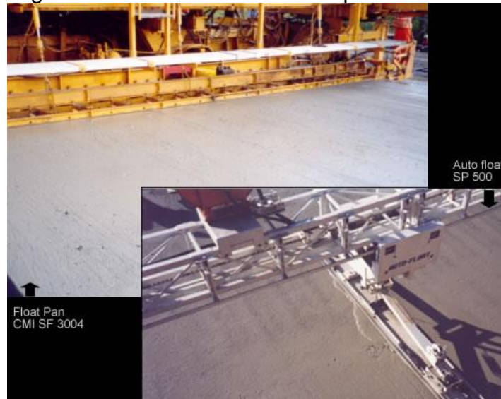
Figura 34: Acabamento – Desempeno mecânico.
