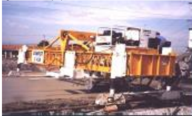
Figura 20: Equipamento de formas-trilho – ABCP.
