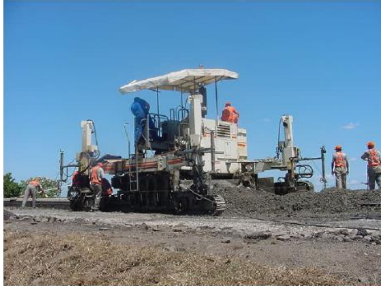
Figura 50: Pavimentadora Wirtgen SP- 500 .
