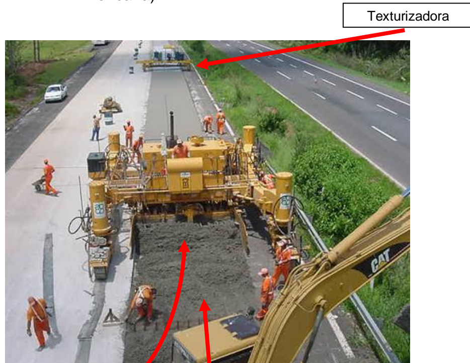
Figura 26: Lançamento do concreto. (Pavimentadora TEREX CMI SF 3004F – Americana).
