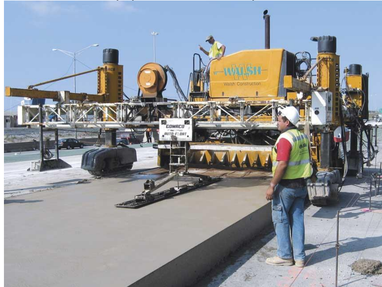
Figura 46: Pavimentadora equipada com desempenadeira mecânica Auto Float .
