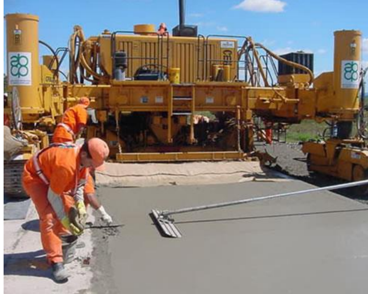
Figura 33: Acabamento – Desempeno manual.
