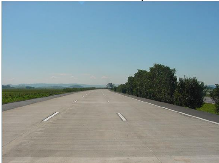
Figura 49: Trecho da rodovia BR – 290 Free Way restaurada com o Whitetopping .
