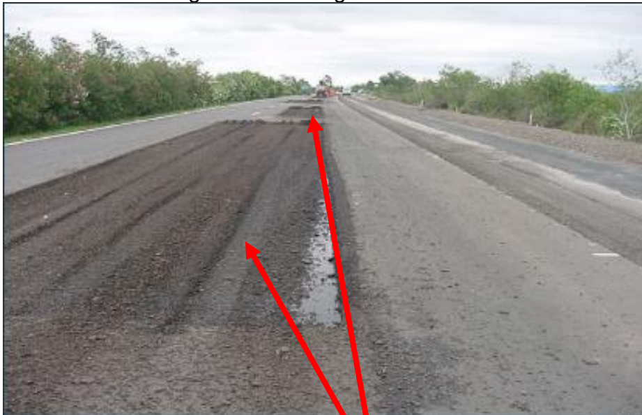
Figura 22: Fresagem do Asfalto.
