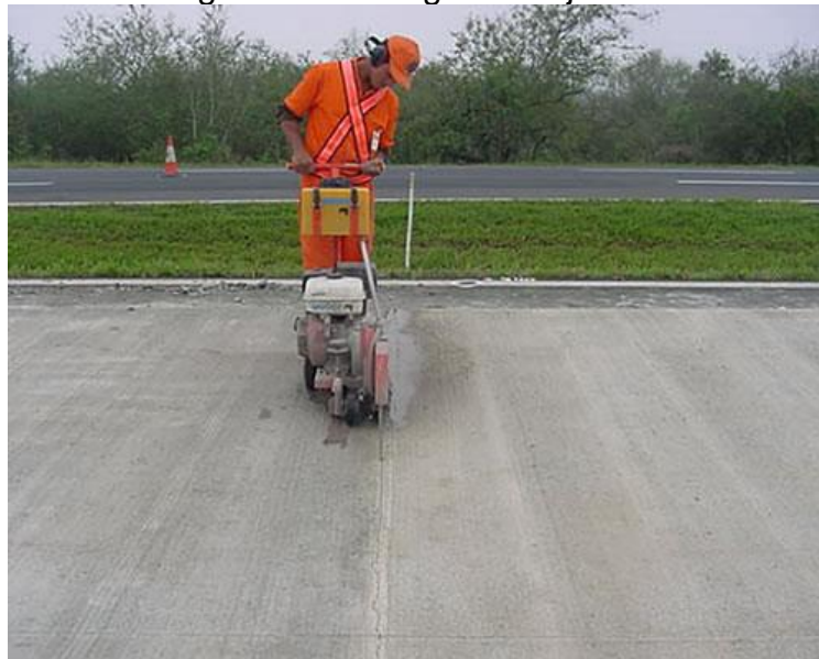
Figura 41: Serragem das juntas.
