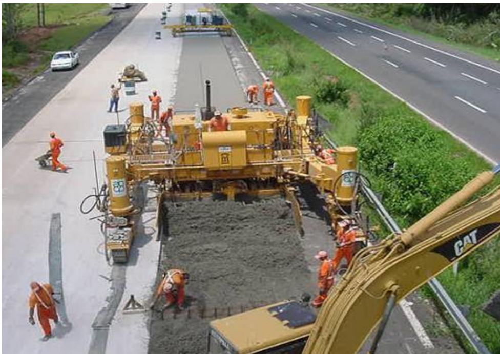
Figura 7: Etapa de lançamento do concreto.
