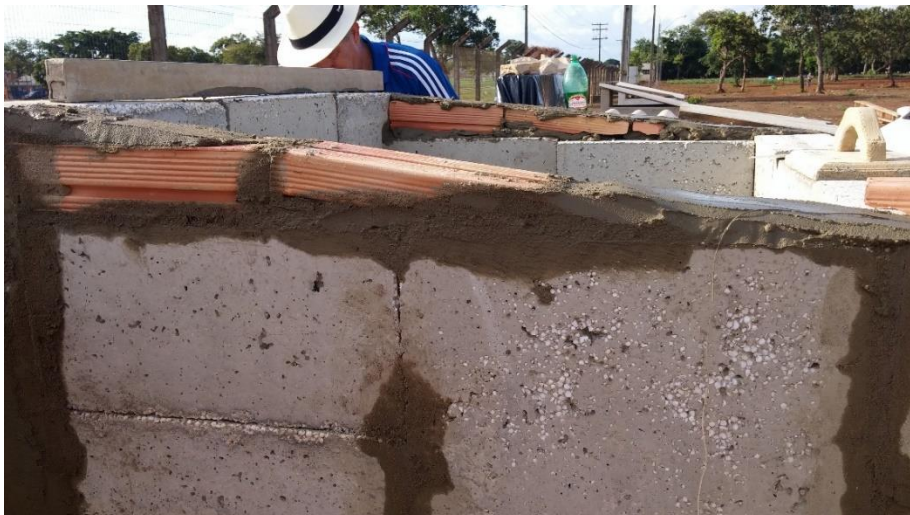
Figura 31: Encunhamento das paredes
