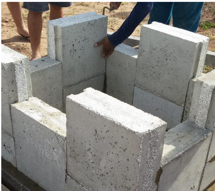
Figura 29: Encaixe dos blocos
