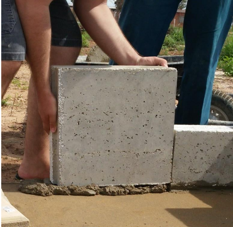
Figura 28: Assentamento da primeira fiada dos blocos
