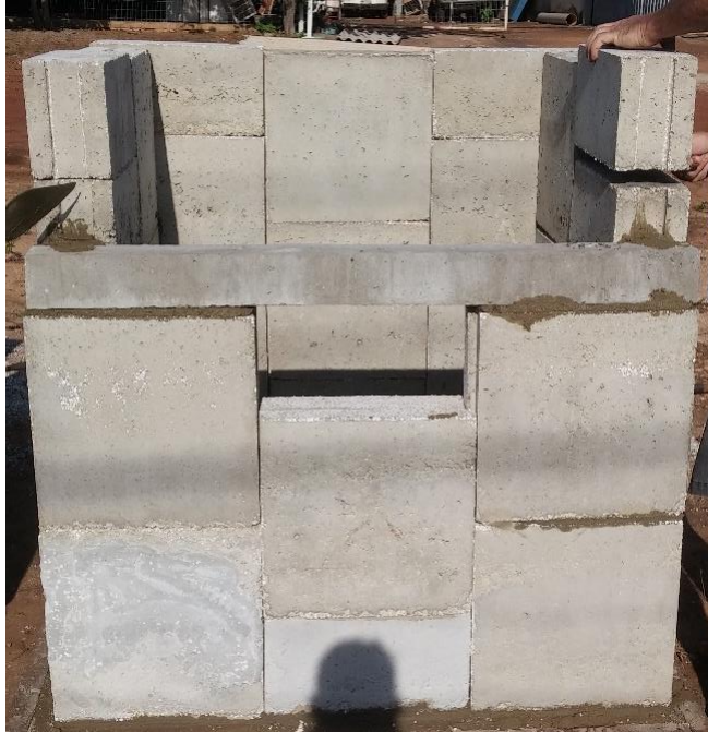
Figura 30: Assentamento de verga de concreto pré-moldado
