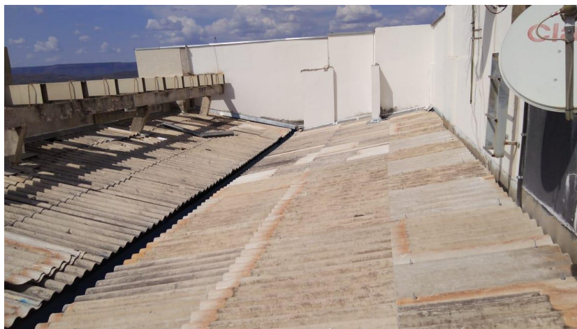
Figura 22: Cobertura do Bloco em Estudo
