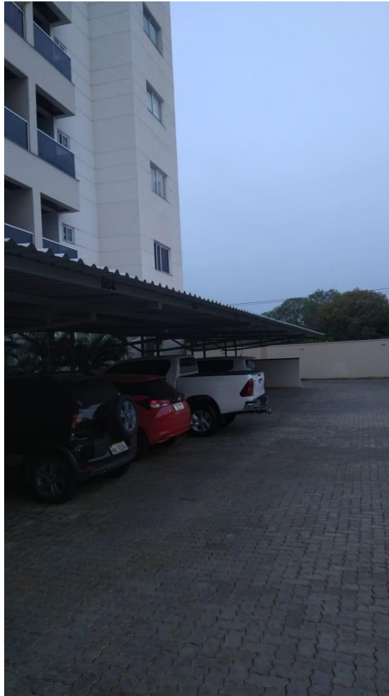
Figura 24: Cobertura da Garagem
