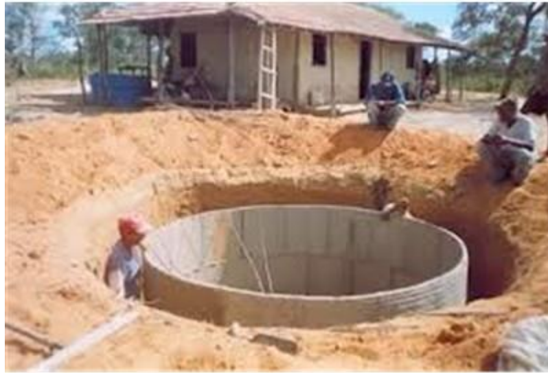
Figura 18: Reservatório em Alvenaria
