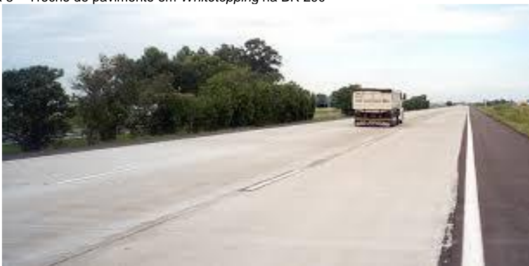
Figura 8 – Trecho de pavimento em Whitetopping na BR 290
