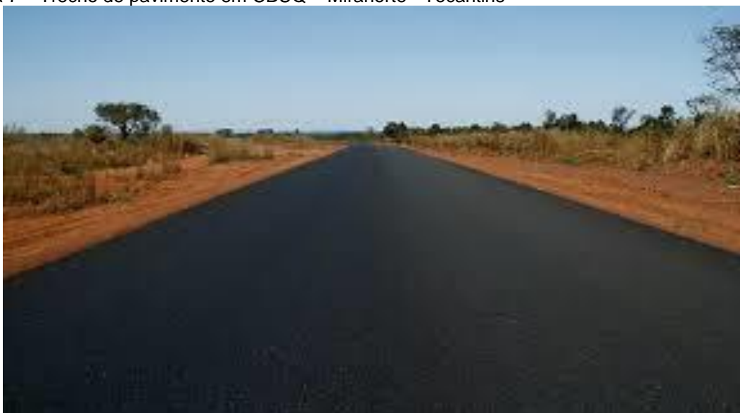
Figura 7 – Trecho de pavimento em CBUQ – Miranorte - Tocantins
