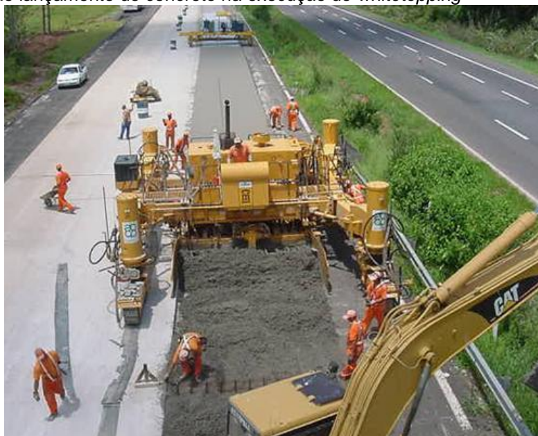
Figura 5 - Etapa de lançamento do concreto na execução do whitetopping
