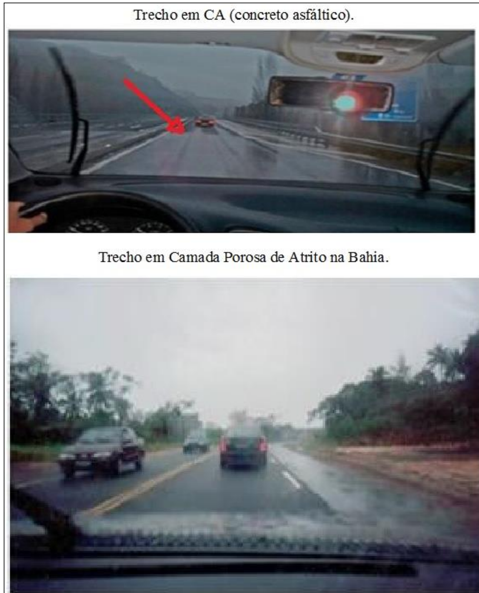
Figura 3 – Diferença de duas misturas asfálticas CA e CPA.
