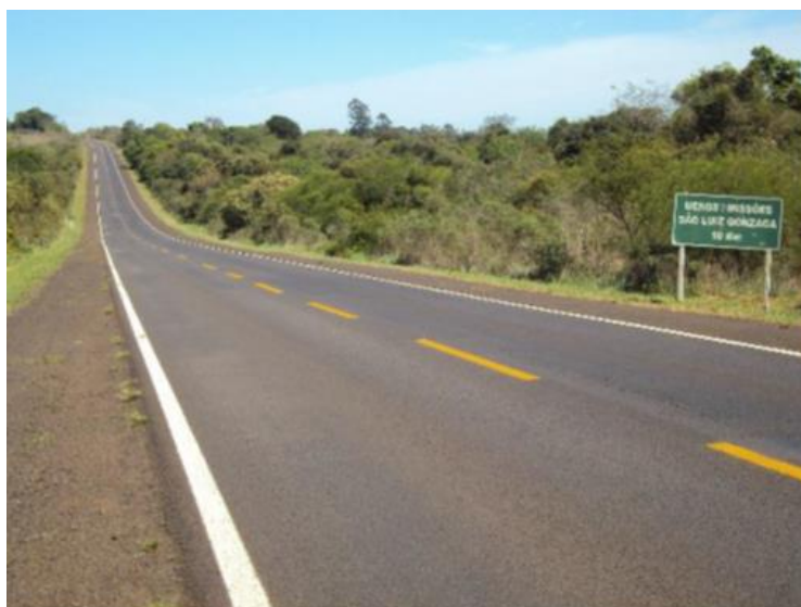
Figura 42: Revestimento em CPA (espessura 4cm), BR-285/RS km 553
