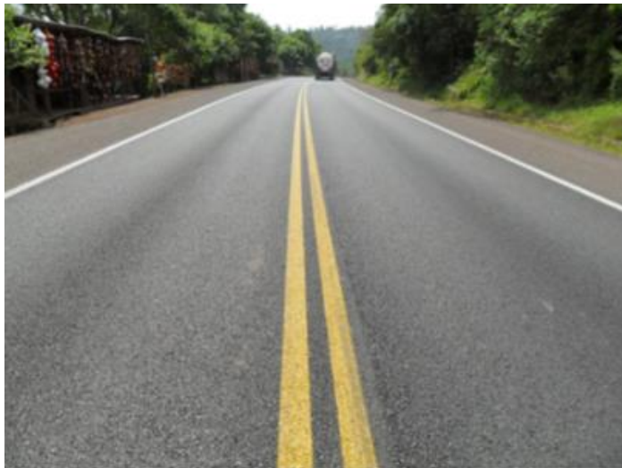
Figura 41: Revestimento em CPA (espessura 5cm), BR-158/386/RS, km 3 ao 4.
