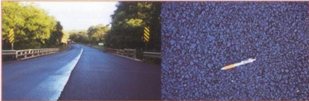
Figura 39 – Gap Graded com Asfalto-Borracha aplicado no Paraná
