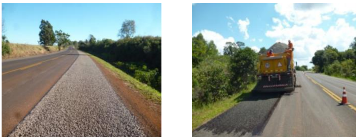
Figura 43: Execução de tratamento superficial BR 468/RS, trecho: Palmeira das Missões-Tiradentes do Sul
