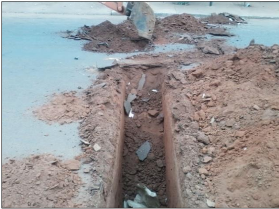
Figura 11 - Abertura de vala com retroescavadeira. Fonte: Do autor (2018)
