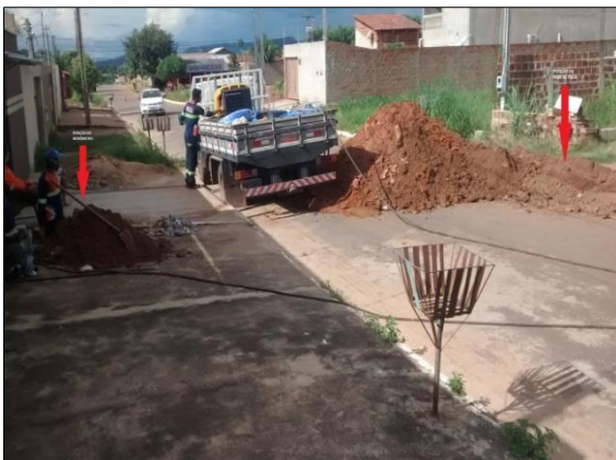
Figura 15 - Posicionamento da rede e do hidrômetro de ligação. Fonte: Do autor (2018)
