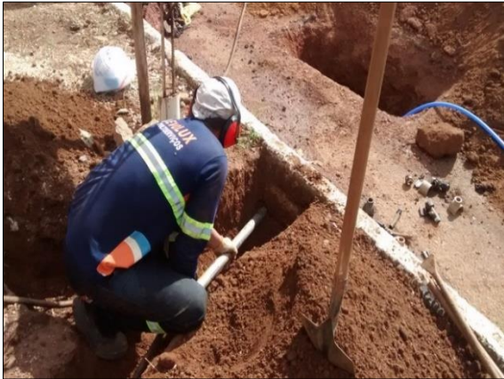
Figura 17 - Encanador lançando haste de perfuratriz através do furo de sondagem. Fonte: Do autor (2018)
