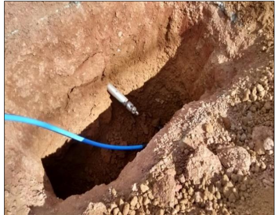
Figura 18 - Chegada de perfuratriz rede de água. Fonte: Do autor (2018)
