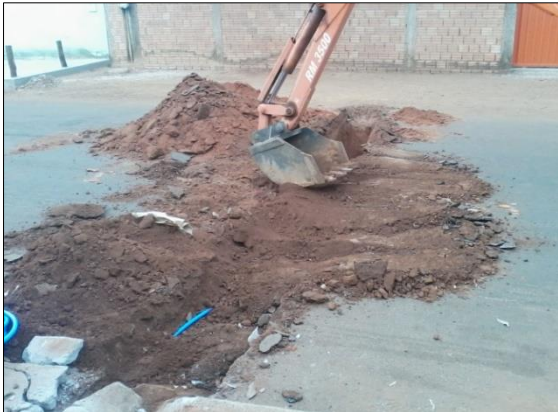
Figura 13 - Fechamento de vala com apoio de retro. Fonte: Do autor (2018)
