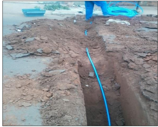
Figura 12 - Extensão de ramal em PEAD da rede ao hidrômetro. Fonte: Do autor (2018)
