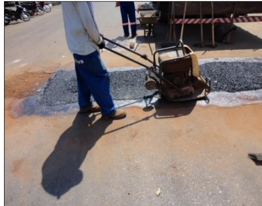
Figura 14 - Recomposição de pavimento asfáltico. Fonte: Do autor (2018)
