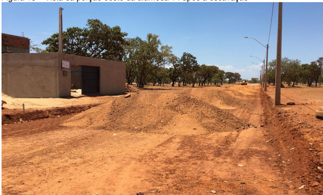
Figura 16 – Vista da porção oeste da alameda 14 após a escavação
