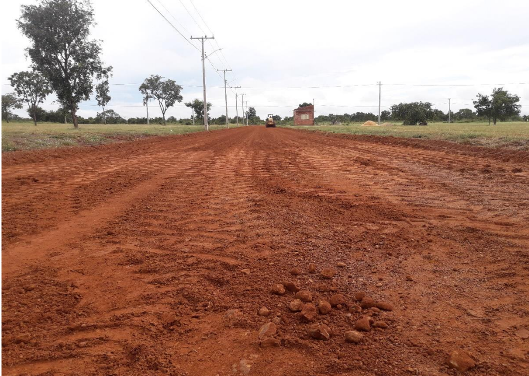
Figura 19 – Trecho da alameda após etapa de rolagem com rolo pé de carneiro
