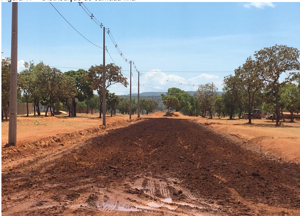
Figura 17 – Distribuição de camada fina
