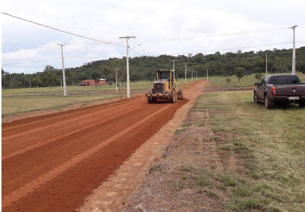
Figura 24 – Vista de trecho da alameda em fase de acabamento
