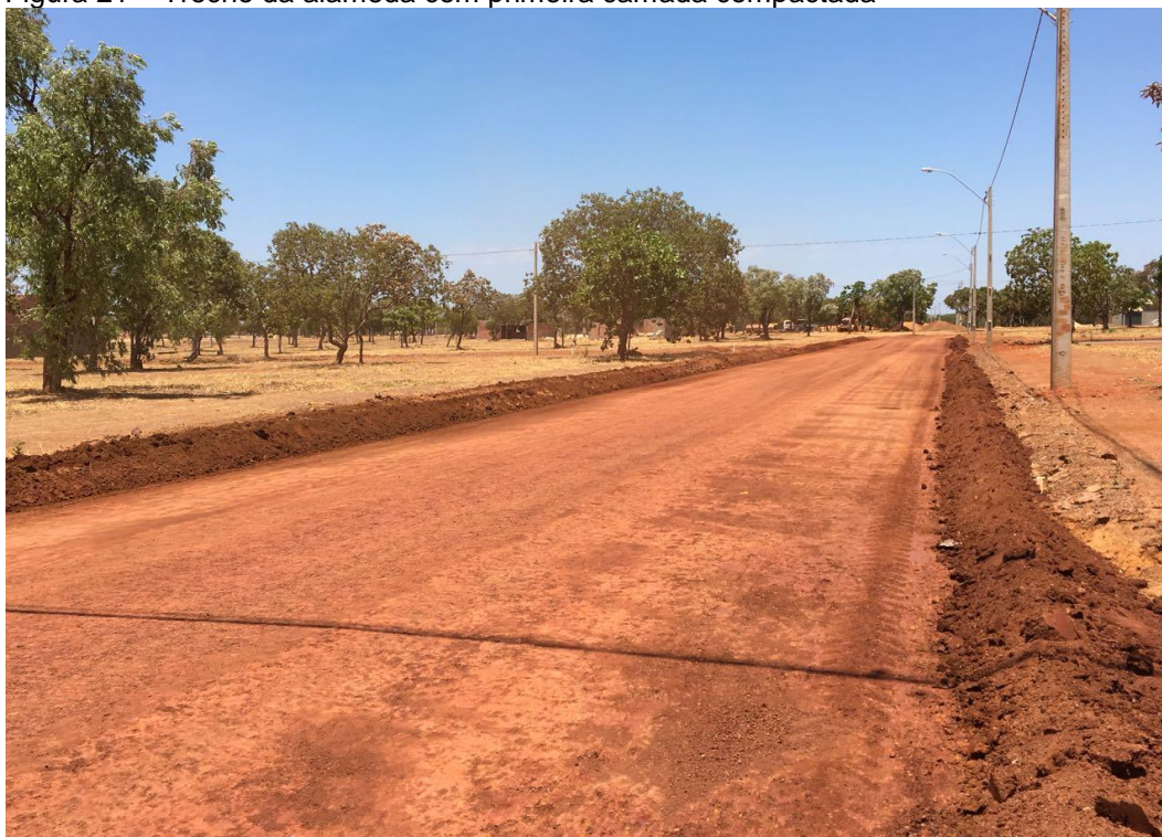
Figura 21 – Trecho da alameda com primeira camada compactada
