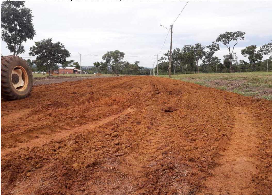
Figura 18 – Alameda após a escarificação e revolvimento do material
