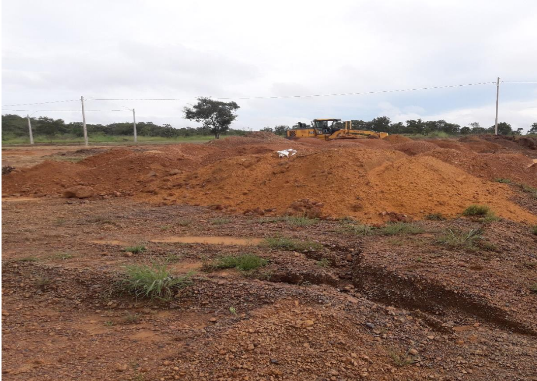
Figura 14 – Vista de área de supressão de vegetação e depósito de material selecionado
