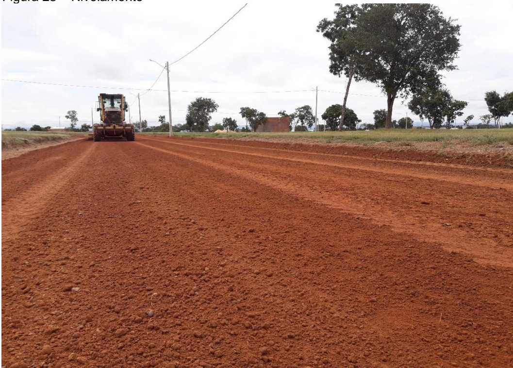
Figura 23 – Nivelamento
