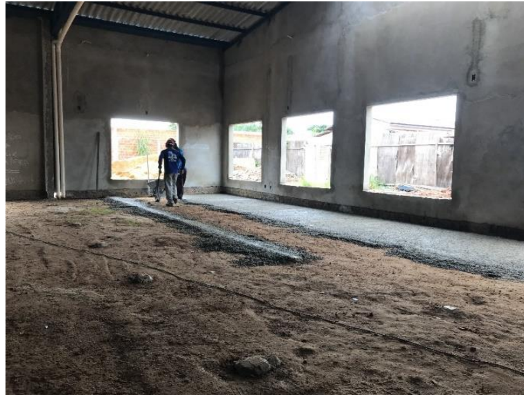
Figura 14 - Execução do serviço de lastro de concreto para piso do Oficial 2.
