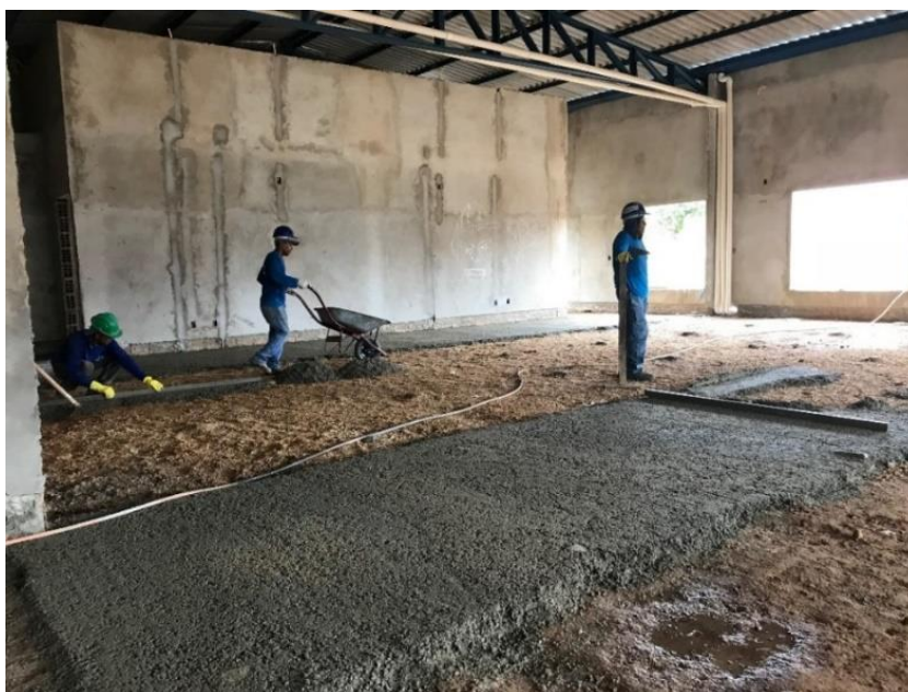
Figura 19 - Execução do piso.
