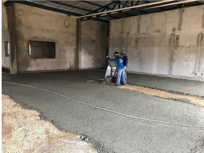
Figura 12 - Execução do lastro de concreto, esp. 5cm do Oficial 1.
