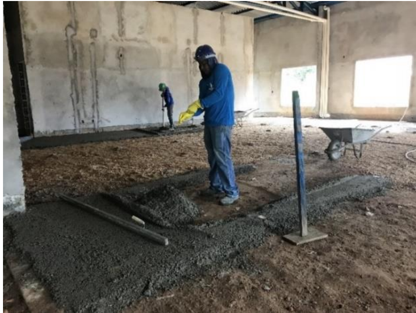
Figura 16 - Execução do serviço de lastro de concreto para piso do Oficial 3.
