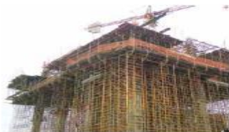
Escoramento de BTM com Cimbre G
