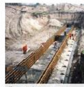
Fôrma para paredes
