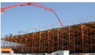
Escoramento de RAPID com Cimbre G
