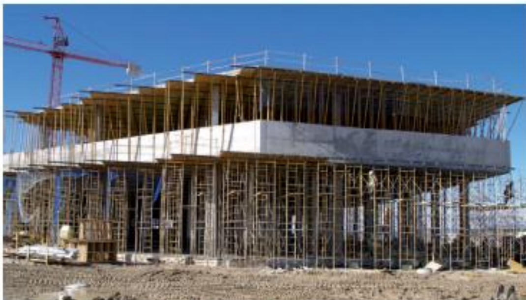
Sistema apto para estruturas horizontais de concreto: lajes, vigas suspensas e capitéis.
