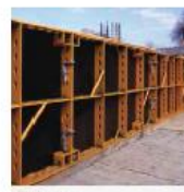
Fôrma para vigas
