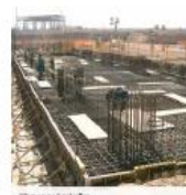
Fôrma para fundações
