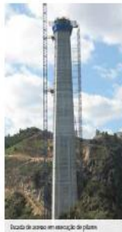
Escada de acesso em execução de pilares.
