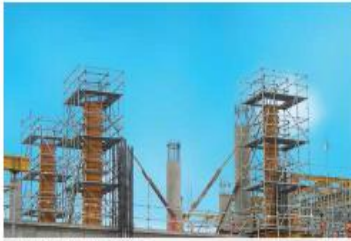
Torres de andaime para consertagens de pilares.
