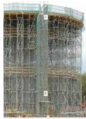
Escoramento para Dintem.
