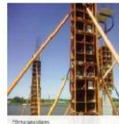
Fôrma para pilares
