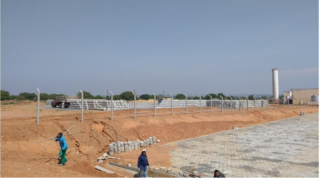
Figura 10: : Pavimentação em bloco sextavado de concreto simples no pátio de manobra do posto Recreio na cidade de Brasiândia do Tocantins - TO
