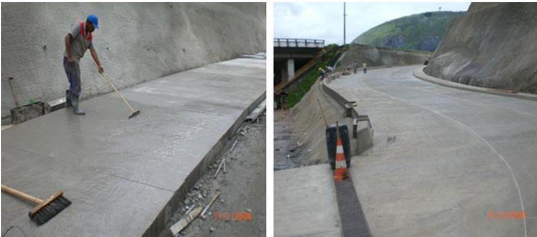
Figura 4: Aplicação de pavimentação rígida.
