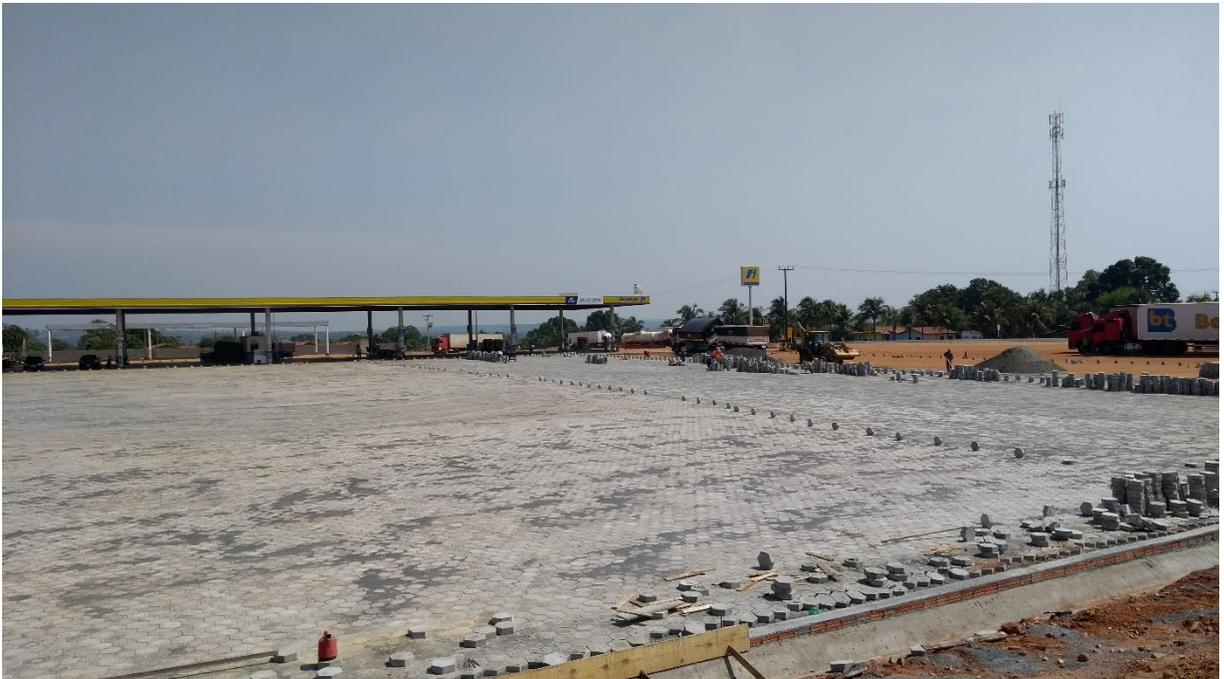
Figura 9: Pavimentação em bloco sextavado de concreto simples no pátio de manobra do posto Recreio na cidade de Brasilândia do Tocantins – TO
