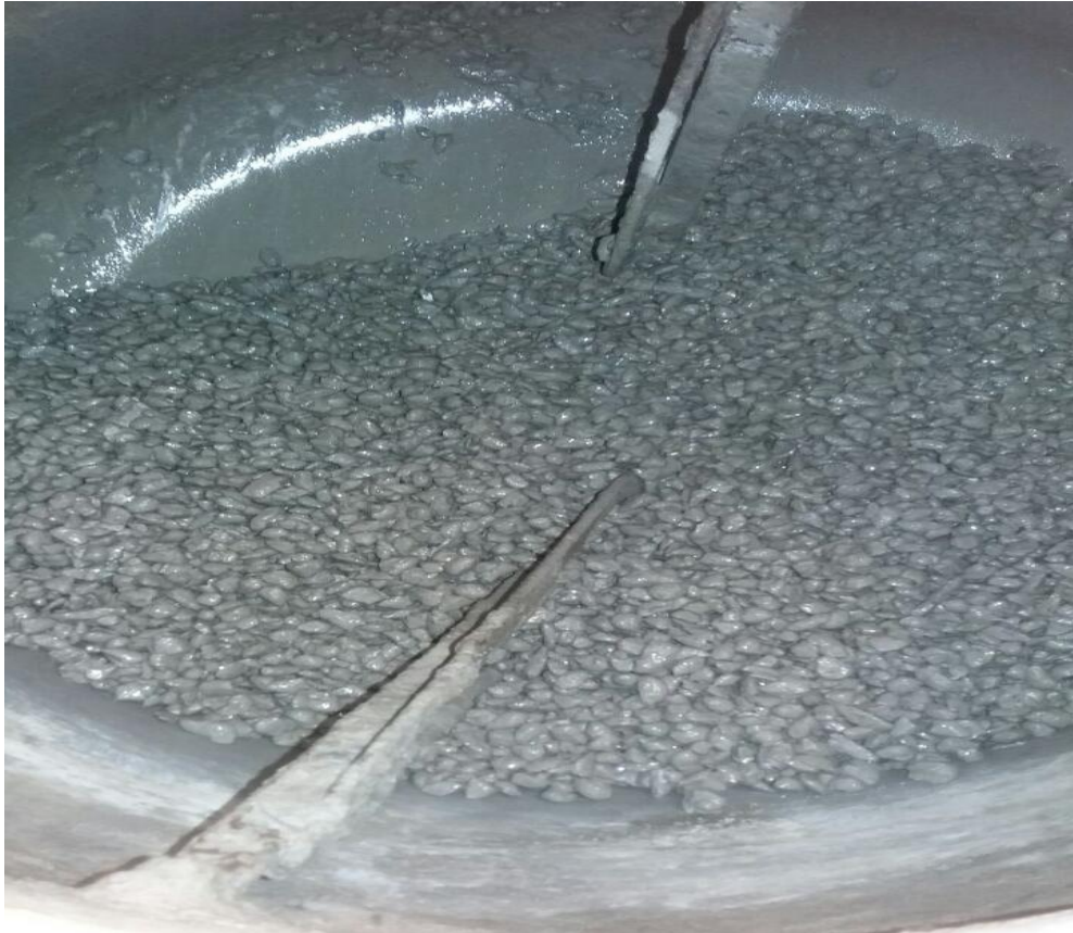
Figura 8: materiais misturados na betoneira.
