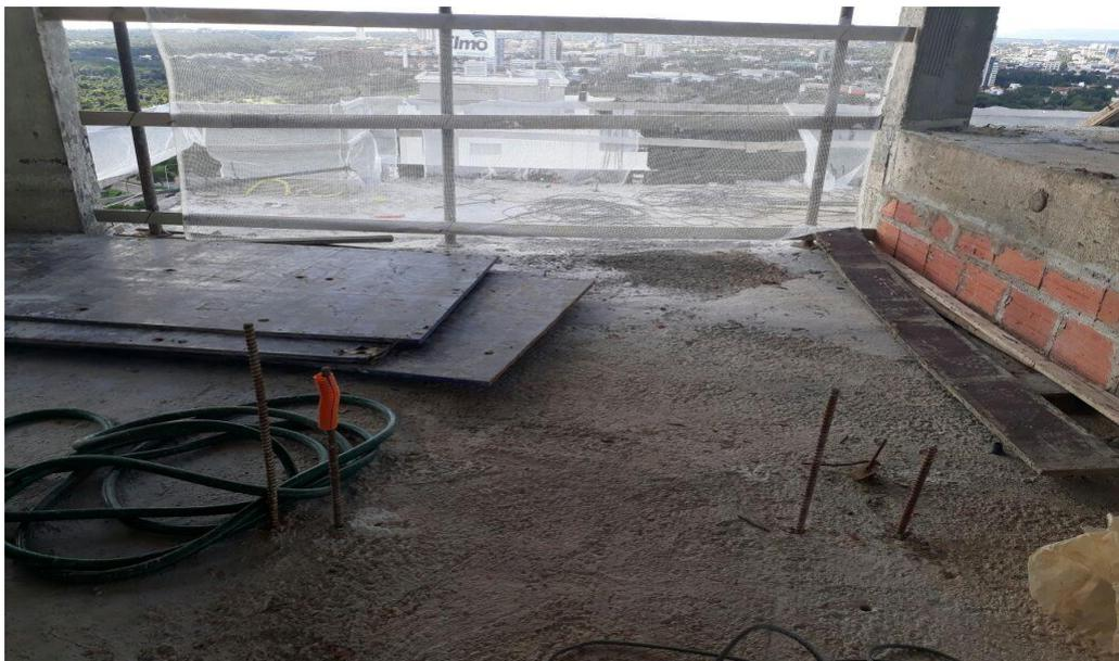
Figura 15- Pontas dos vergalhões sem proteção contra acidentes – Obra 02
