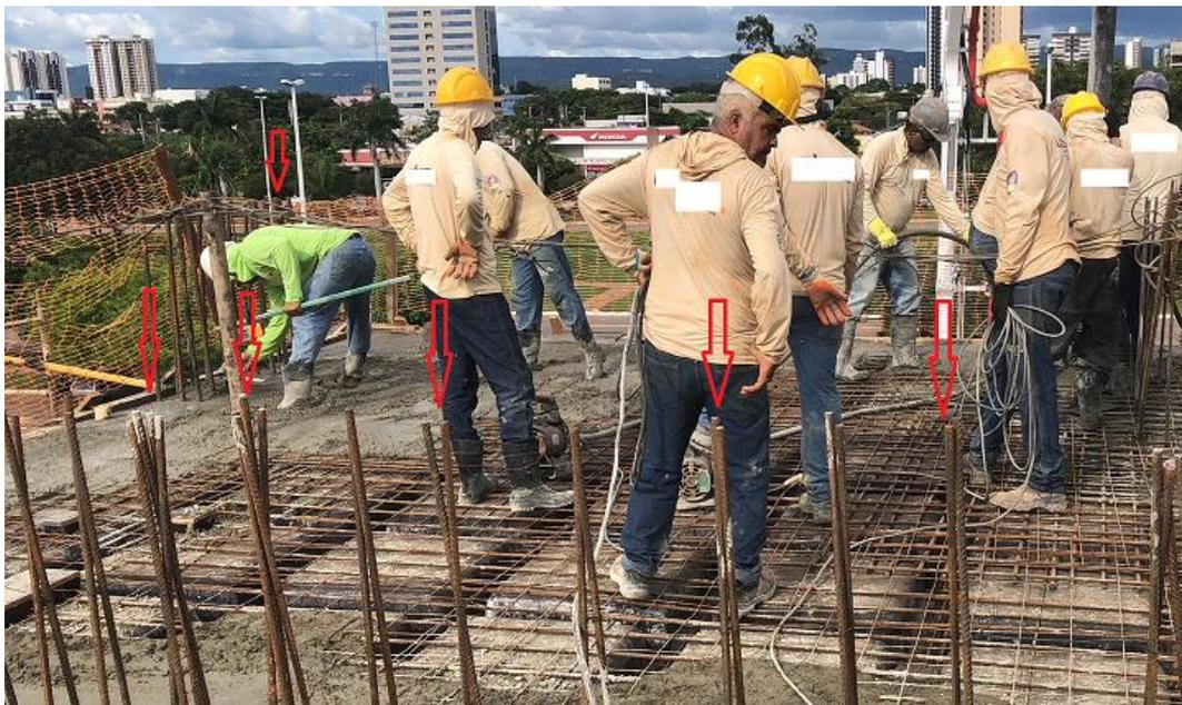
Figura 17 -Pontas dos vergalhões sem proteção contra acidentes – Obra 01
