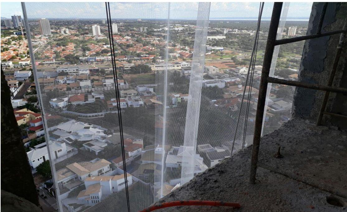
Figura 20- Falta de guarda-corpo – Obra 02
