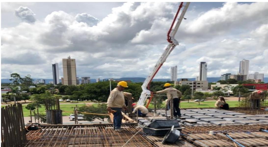
Figura 19-Falta de guarda-corpo e cinto de segurança – Obra 01
