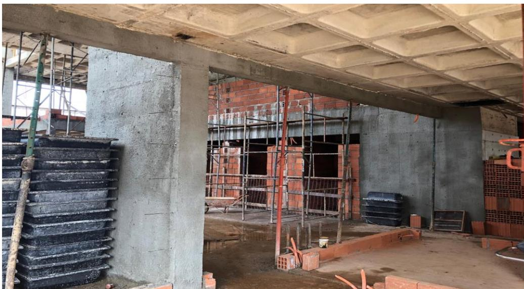
Figura 16- Pontas dos vergalhões sem proteção contra acidentes – Obra 01
