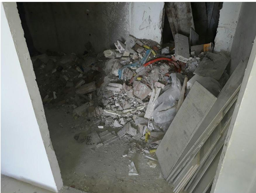
Figura 11- Armazenamento inadequado dos entulhos – Obra 02
