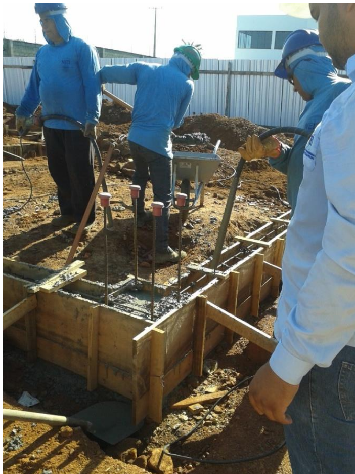
Figura 20- Utilização de vibrador de imersão
