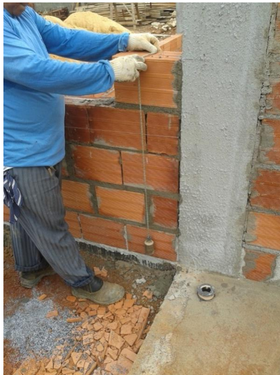
Figura 29- Aferição de prumo em alvenarias
