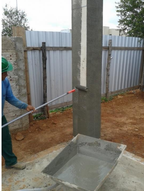
Figura 28- Execução de chapisco rolado
