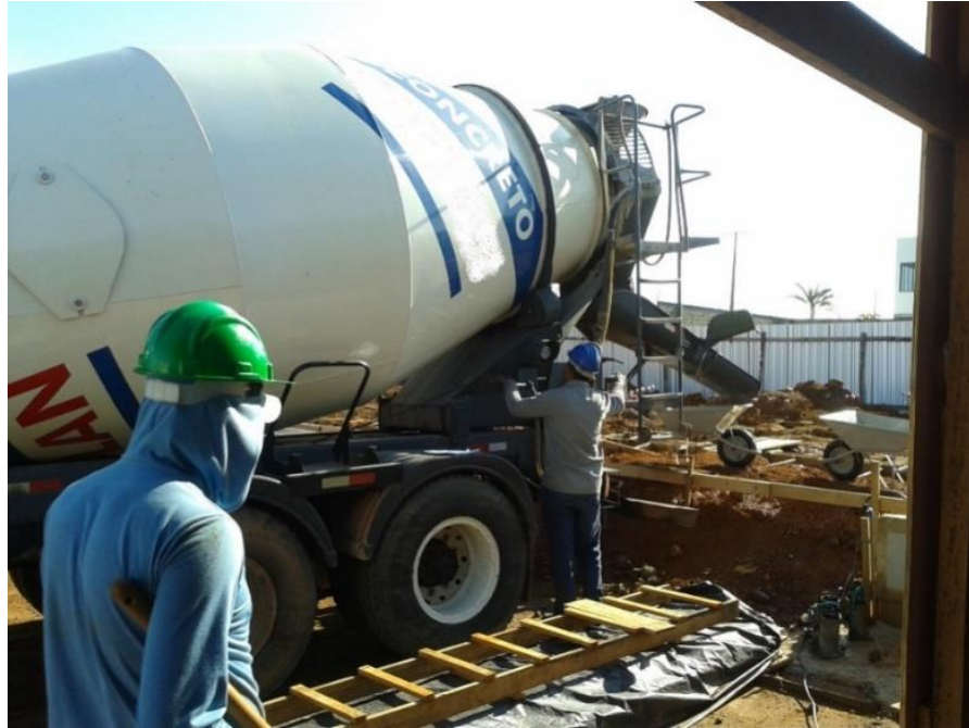
Figura 31–Utilização de Concreto Usinado
