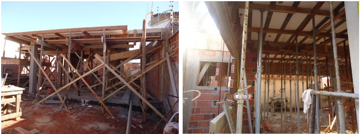
Figura 14 - Método - Escoramento
