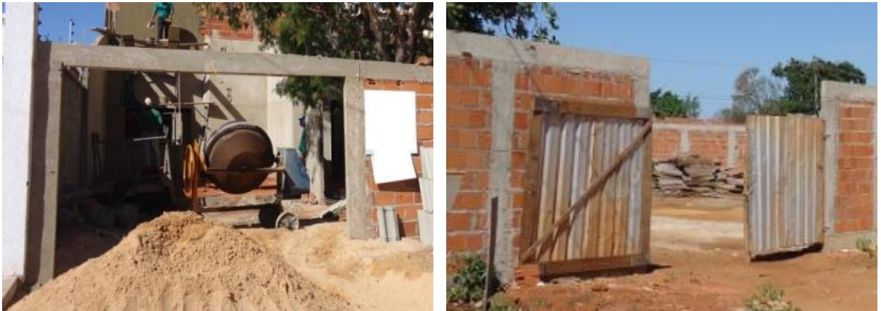
Figura 13- Meio - Abertura de entrada da obra
