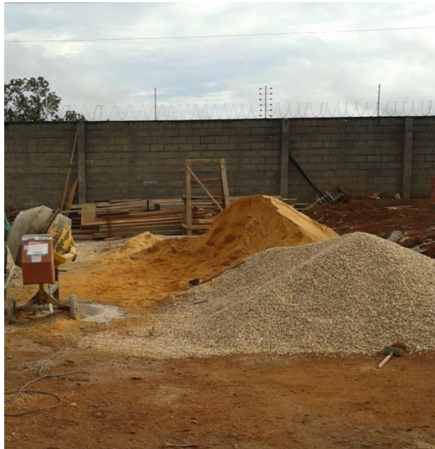
Figura 26- Materiais locados próximo ao local de preparo
