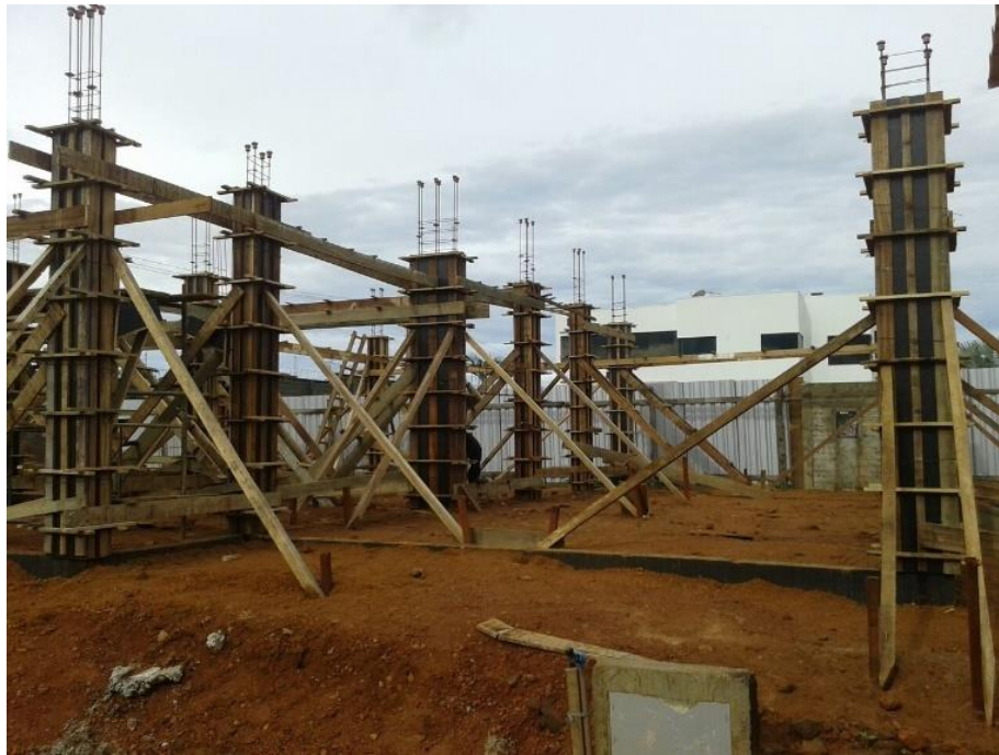
Figura 19- Utilização de formas reaproveitáveis
