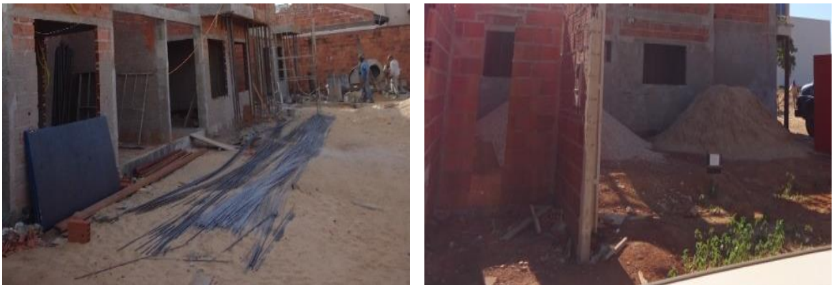
Figura 12 - Meio - Organização dos materiais de construção
