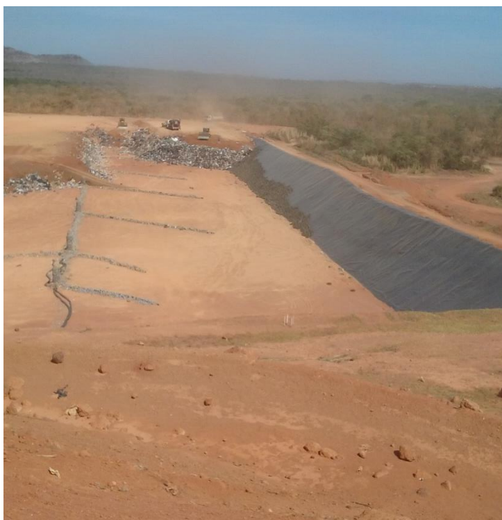
Figura 6– Aterro Sanitário de Palmas – TO.
