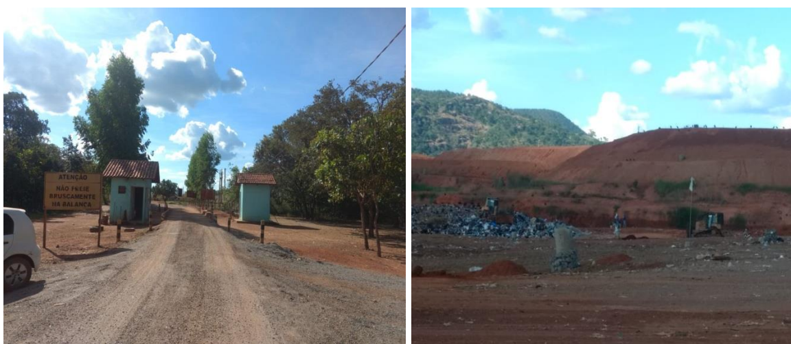
Figura 8 – Áreas com déficit de isolamento e sinalização. Fonte: Autor, 2018.
