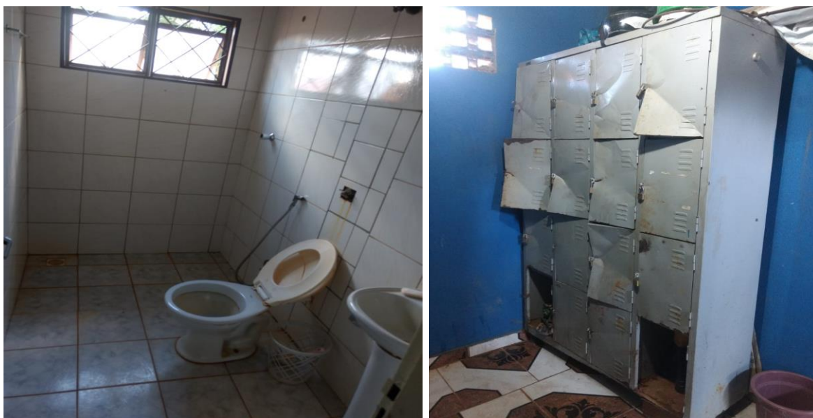
Figura 13 – Banheiros / Vestiários. Fonte: Autor, 2018.
