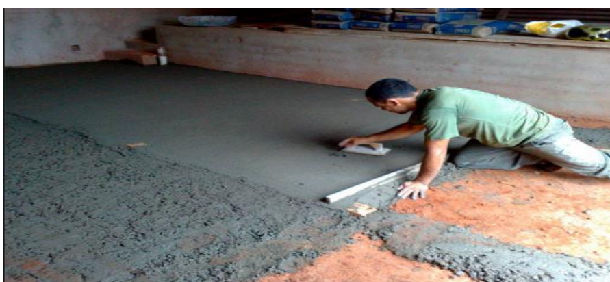
Figura 2: Procedimento de execução do contrapiso convencional.
