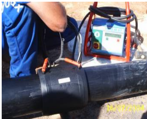
Figura 10: Conexões soldadas
