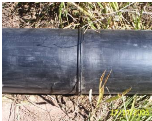
Figura 11: Solda de Topo
