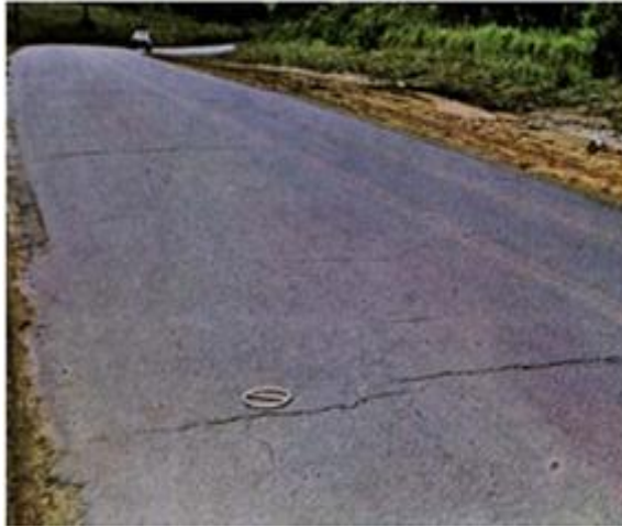
Figura 10 - Trinca transversal:
