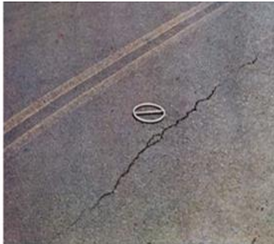
Figura 11 – Trinca longitudinal
