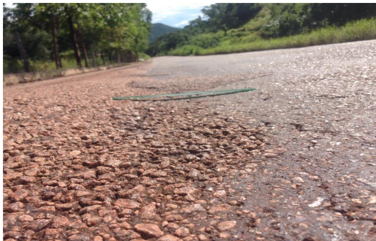
Figura 42 - Afundamento Local
