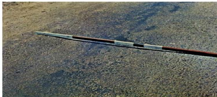
Figura 15 - Afundamento Plástico
