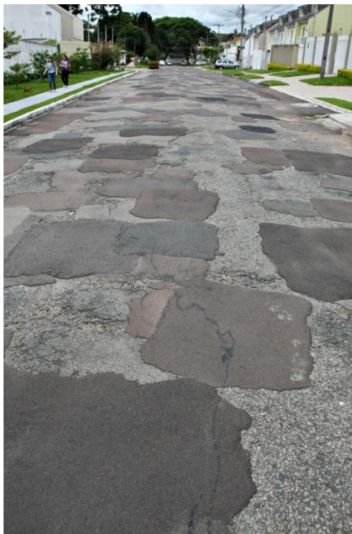
Figura 21 - Remendo superficial
