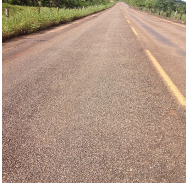
Figura 39 - Desgaste superficial
