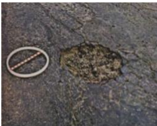
Figura 20 - Panela ou buraco.
