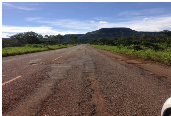
Figura 40 - Remendo
