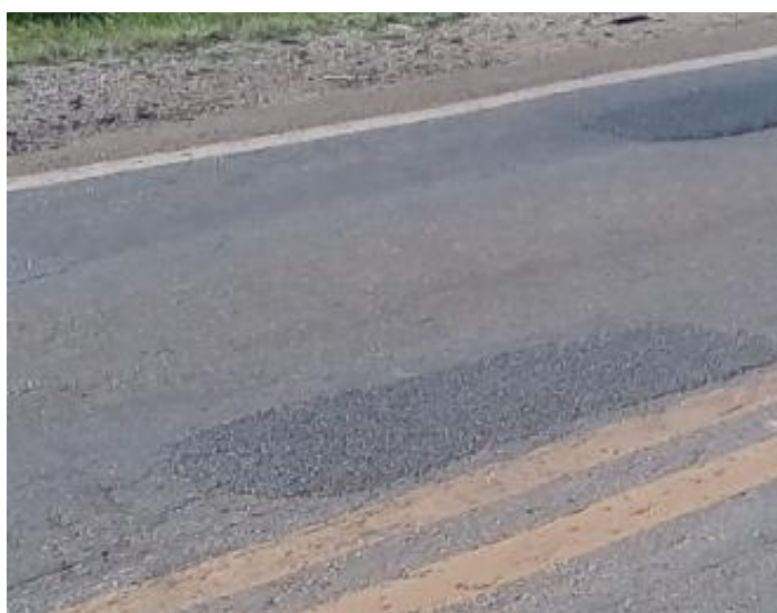
Figura 36 - Remendo
