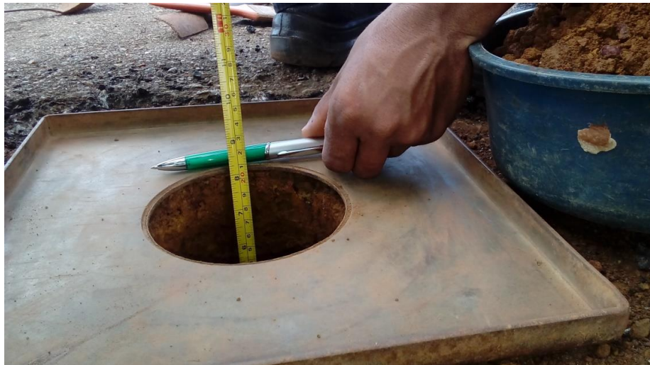
Figura 31 - Verificação das espessuras das camadas e retirada dos materiais
