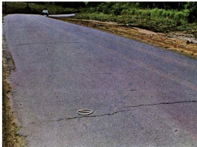
Figura 12 - Trinca transversal
