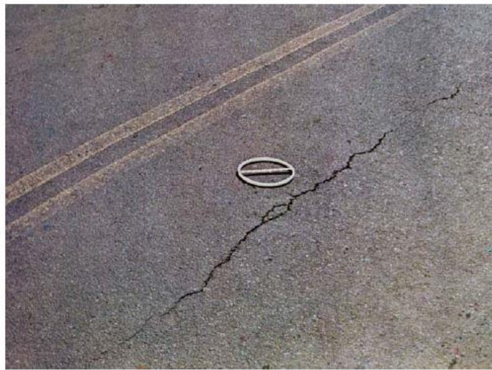
Figura 13 - Trinca longitudinal
