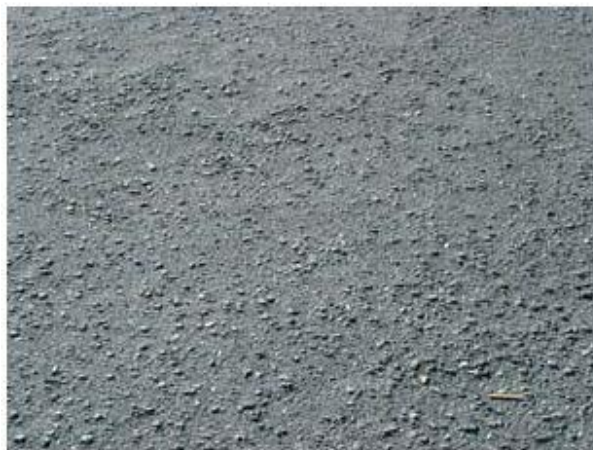
Figura 23 - Desgaste
