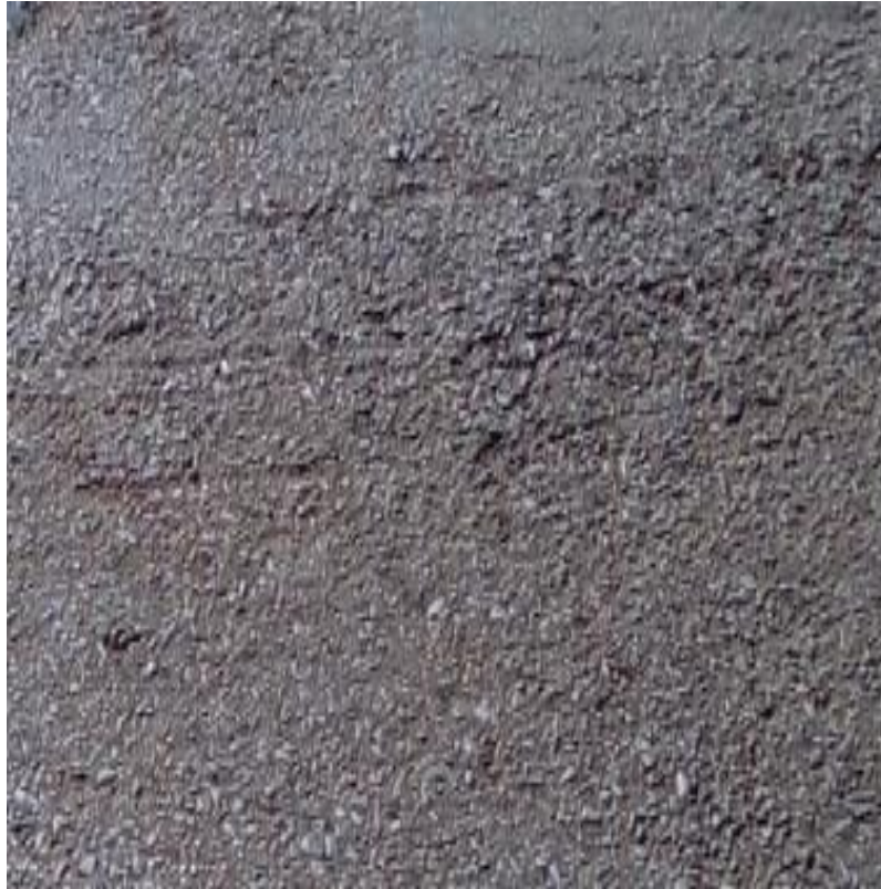
Figura 37 – Desgaste superficial
