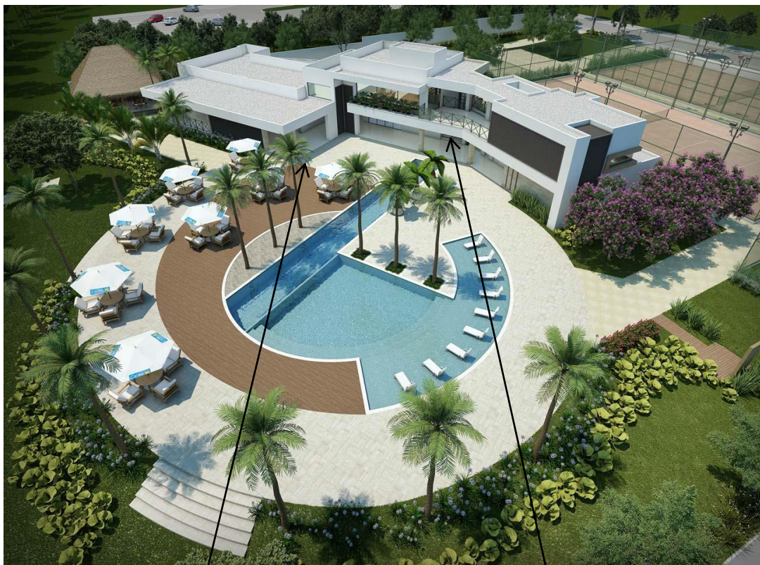
Figura 19: Rampa e escada que não seguem as recomendações da NBR 9050:2015
