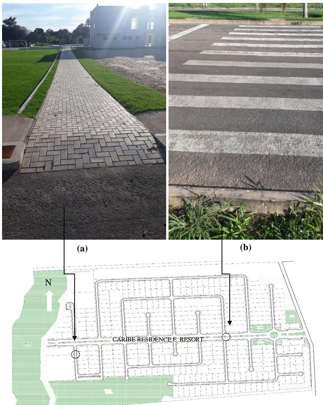
Figura 21: Localização dos pontos que possuem rebaixamentos de calçadas e sinalização
