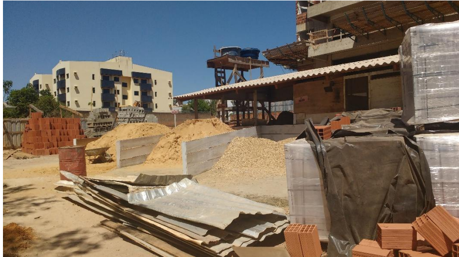
Figura 5 - canteiro de obras
