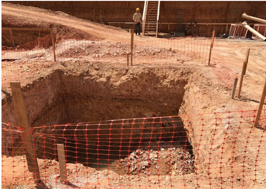
Figura 23- Bloco de fundação
