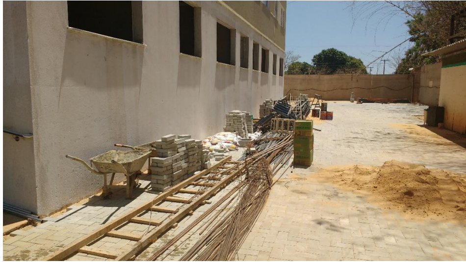
Figura 15- frente da obra
