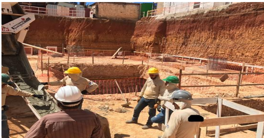
Figura 22 – Locação das Fundações
