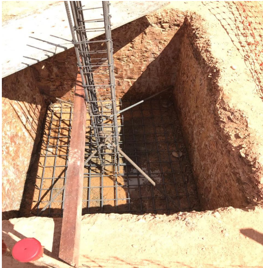
Figura 25 – Sapata de fundação
