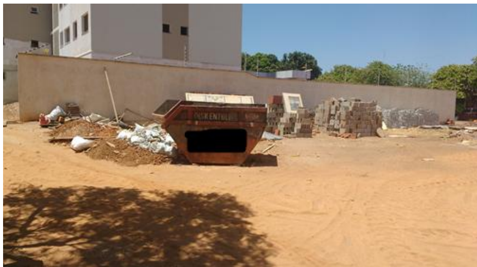
Figura 17 – Local de deposito dos materiais e resíduos
