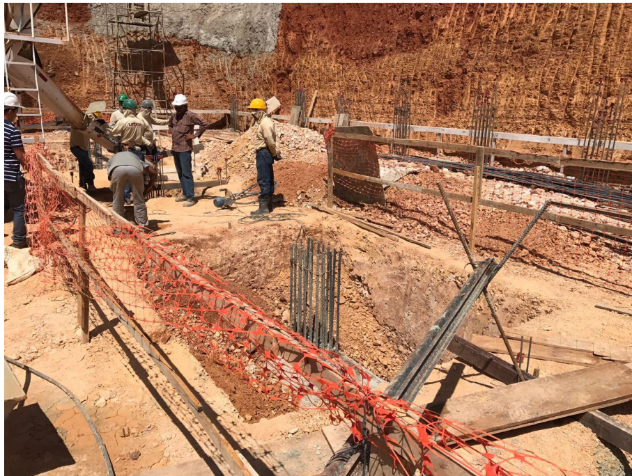
Figura 24 – Concretagem e sapata de fundação
