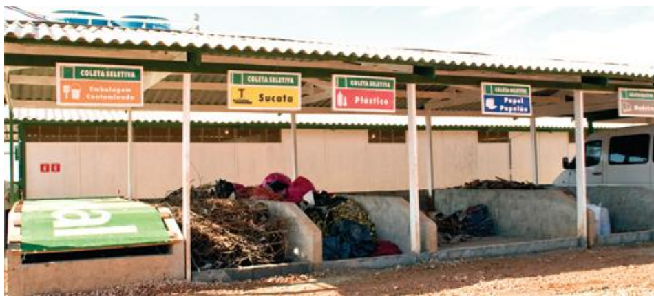
Figura 1- Exemplo de organização de RCC no canteiro de obras
