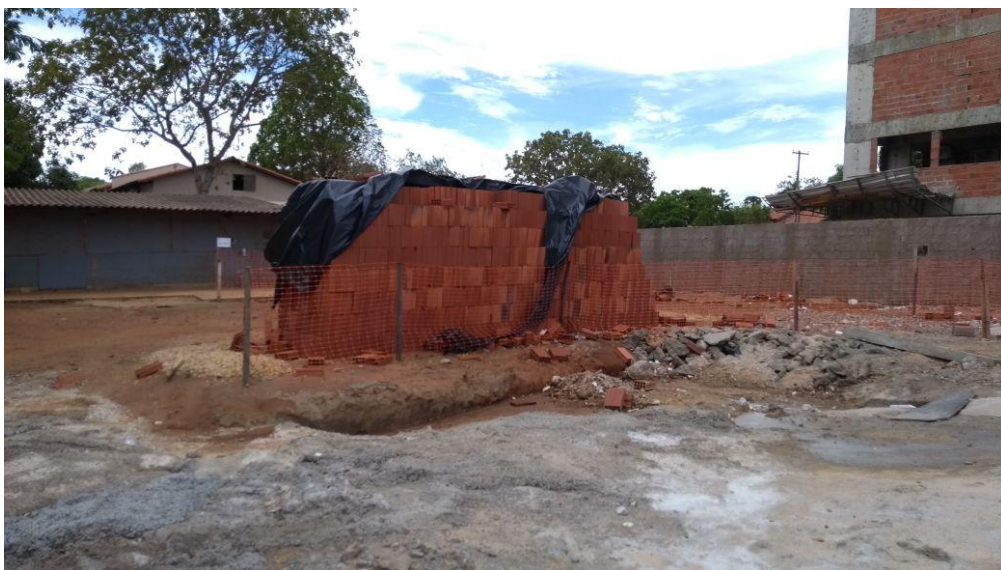
Figura 28 – Materiais no canteiro de obras.
