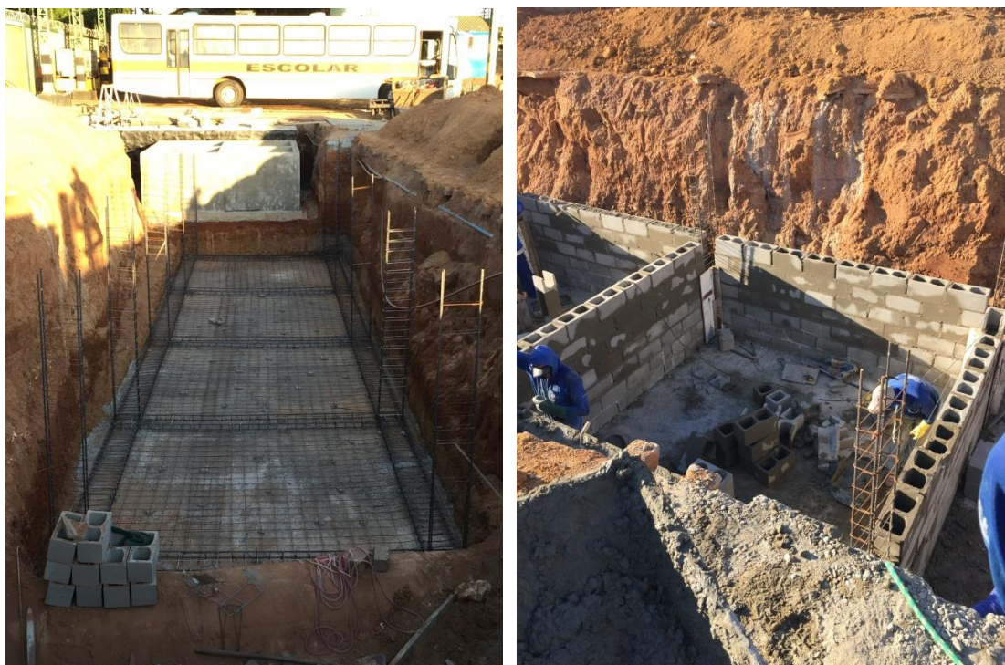
Figura 28 – Construção dos Reatores Biológicos
