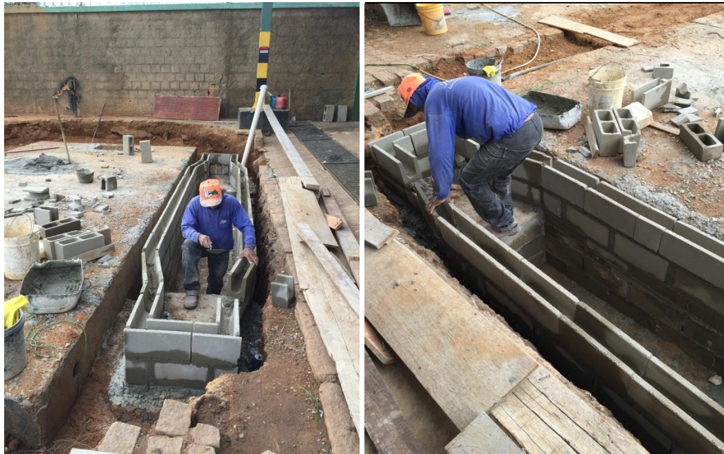
Figura 25 – Construção do Desarenador.
