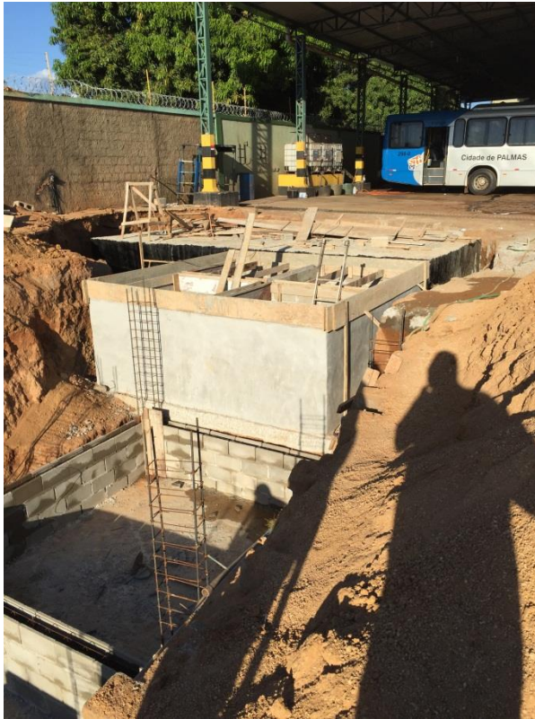
Figura 27 – Construção do Equalizador
