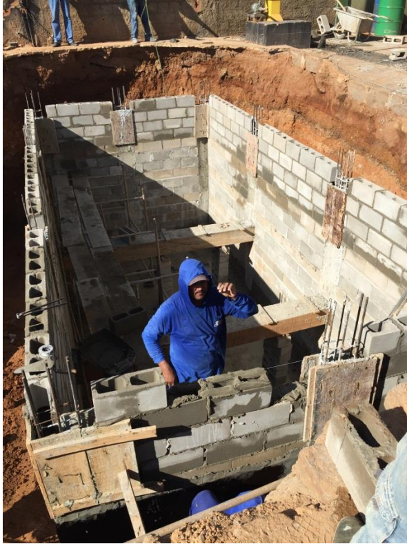
Figura 26 – Construção da Elevatória 1 – capacidade de aproximadamente 80m 3 .
