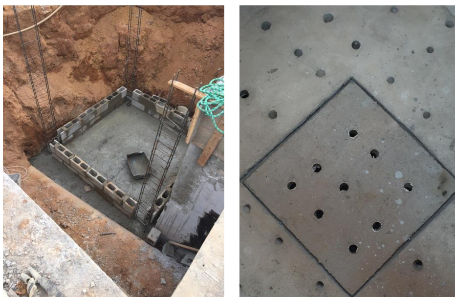
Figura 29 – Construção do Filtro Anaeróbio e poros em PVC do mesmo.
