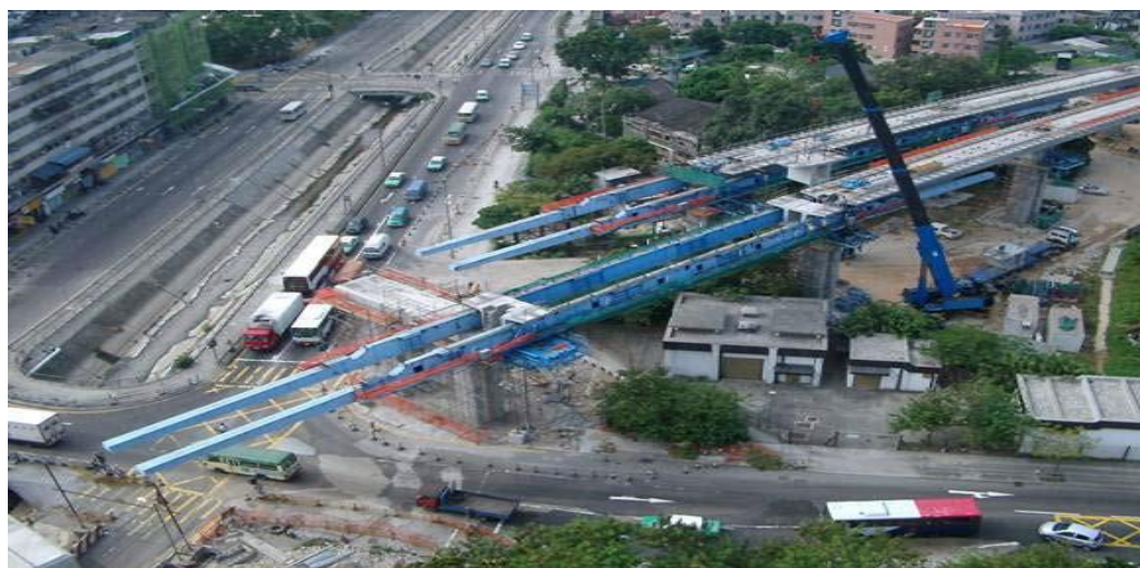
Figura 22: Lançadeira inferior de aduelas
