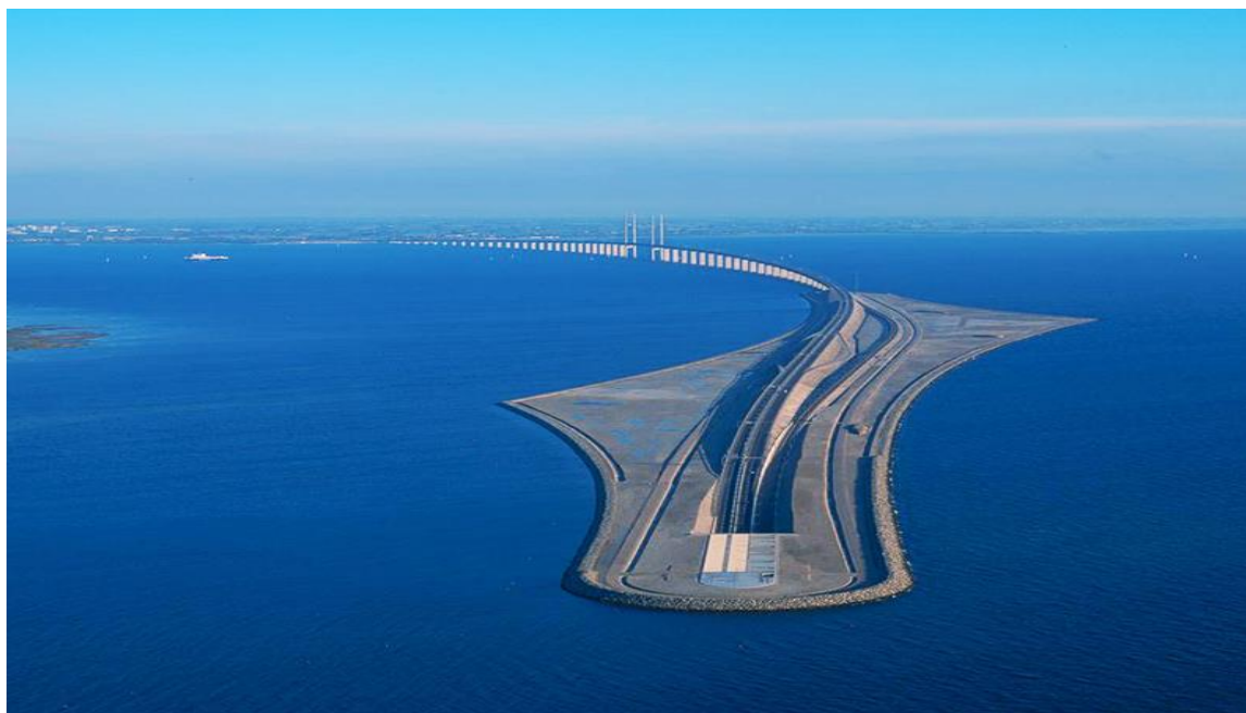
Figura 3- Ilha artificial e entrada para parte submersa da Ponte Öresund
