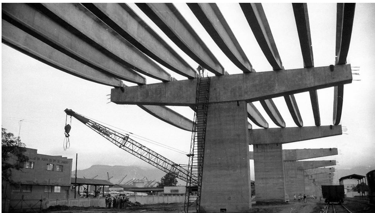
Figura 11- montagem das vigas pré-fabricadas da Ponte Rio-Niterói
