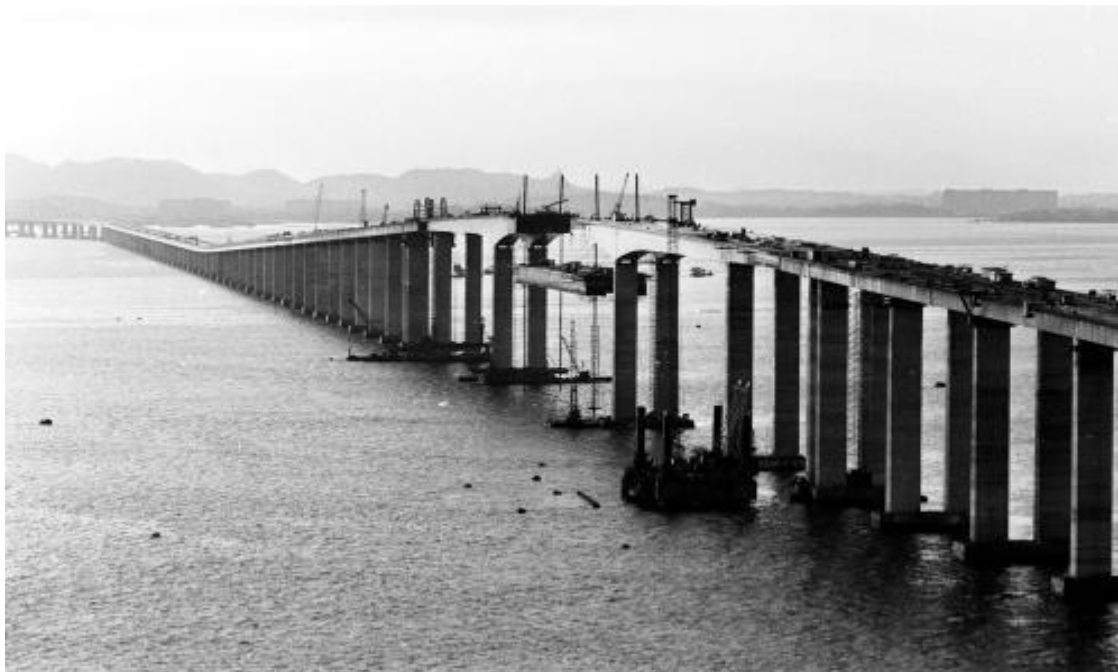
Figura 21- Içamento do vão central de 300 metros
