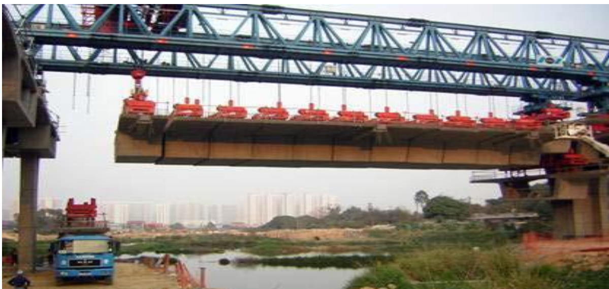
Figura 6- Lançadeira superior de aduelas pelo método de avanços progressivos
