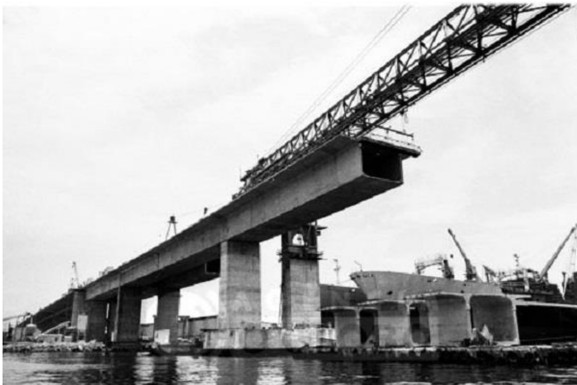
Figura 28: Içamento das aduelas por guindastes acoplados na treliça
