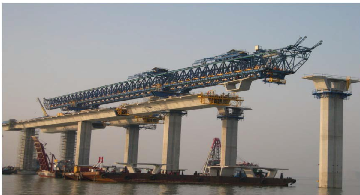
Figura 7- Lançadeira superior de aduelas pelo método de avanços sucessivos
