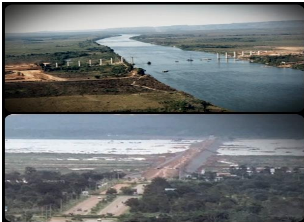
Figura 13- Construção da Ponte FHC
