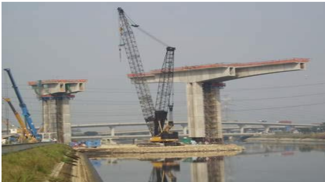
Figura 24: Elevação de aduelas por guias
