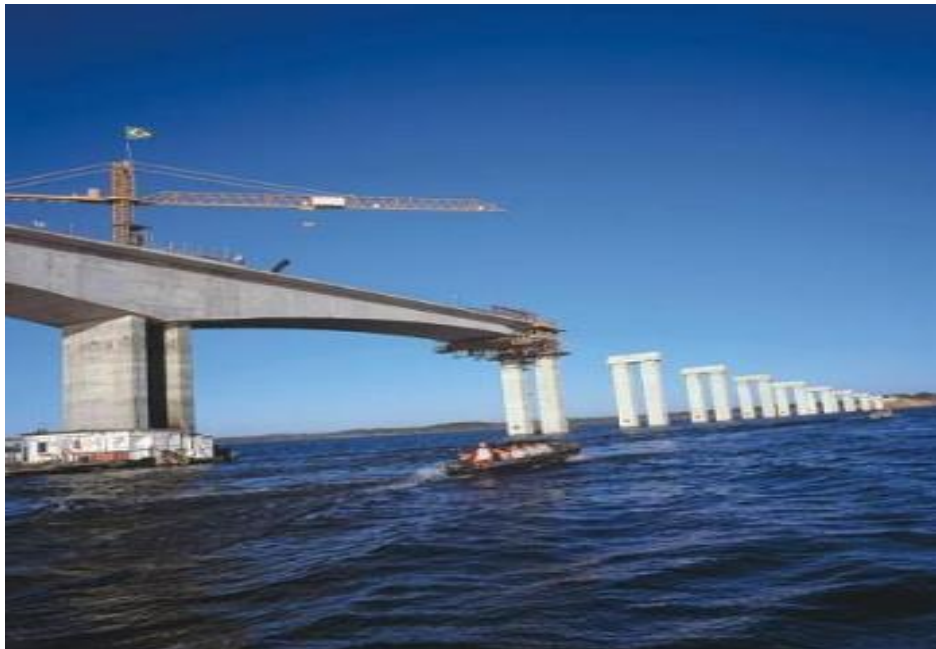
Figura 12- Construção do vão central da ponte FHC
