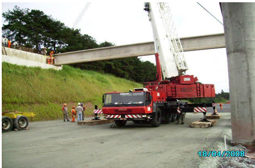
Figura 30: Montagem das vigas pré-moldada por guindaste sobre rodas
