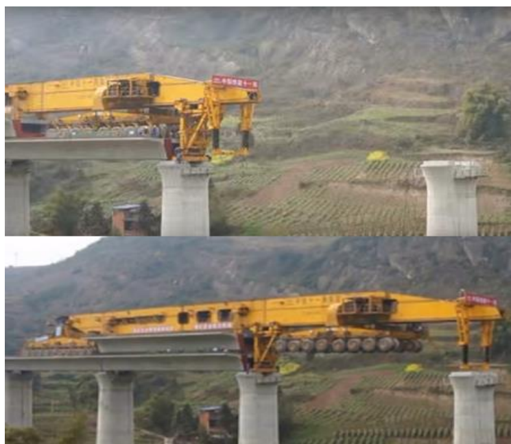
Figura 18- Chegada da SLJ900/32 à borda já construída e projeção de seu eixo ao próximo pilar
