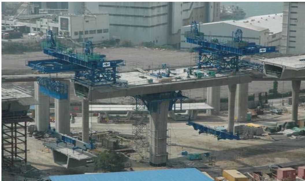
Figura 25: Elevação de aduelas por guincho
