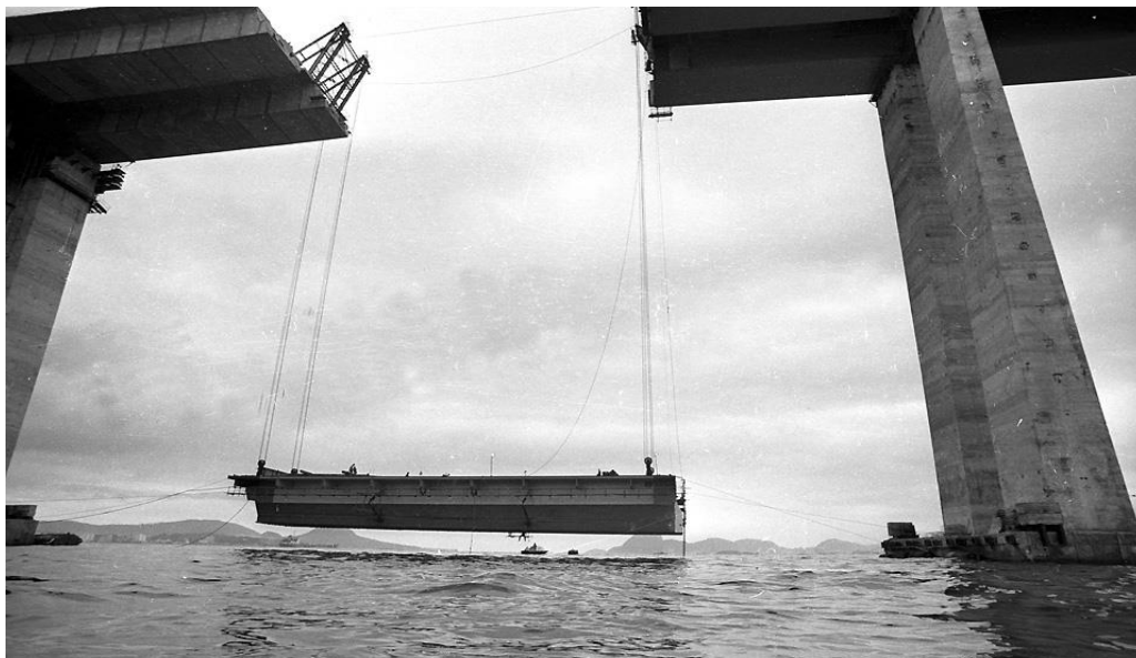
Figura 9- Içamento do vão central da Ponte Rio-Niterói
