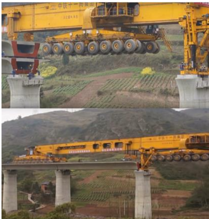
Figura 19- Trabalhadores configurando a SLJ900/32 e posicionamento final da peça.
