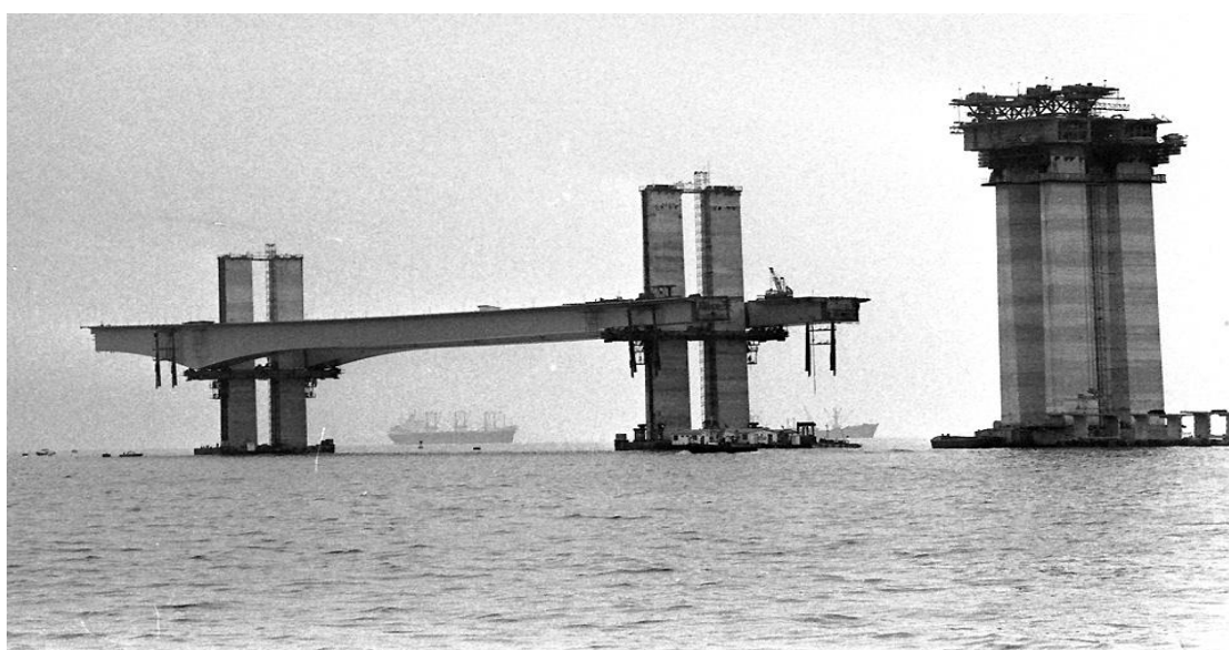
Figura 20- Içamento do vão central de 200 metros
