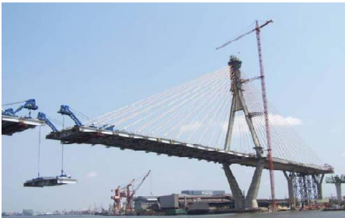
Figura 27: Construção de ponte com recurso a tirantes definitivos (ponte atirantada)
