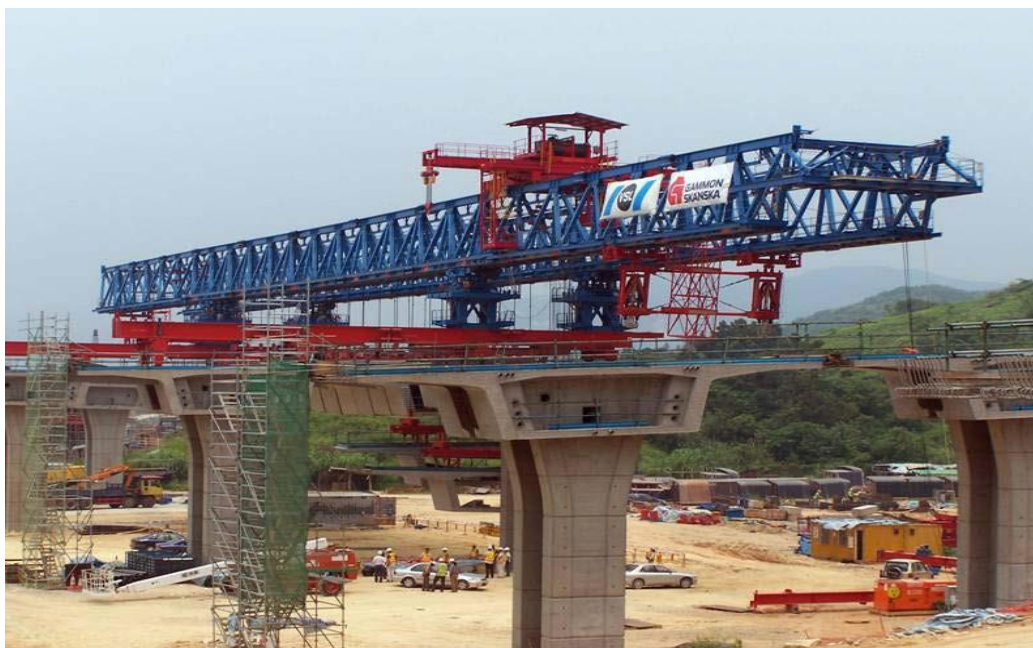
Figura 26: Treliza lançadeira superior por avanços sucessivos.
