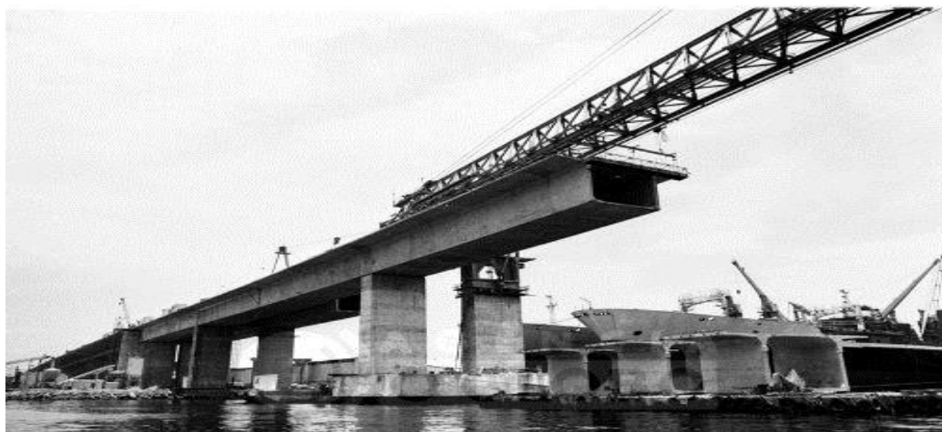
Figura 10- Montagem das aduelas pré-moldadas da Ponte Rio-Niterói
