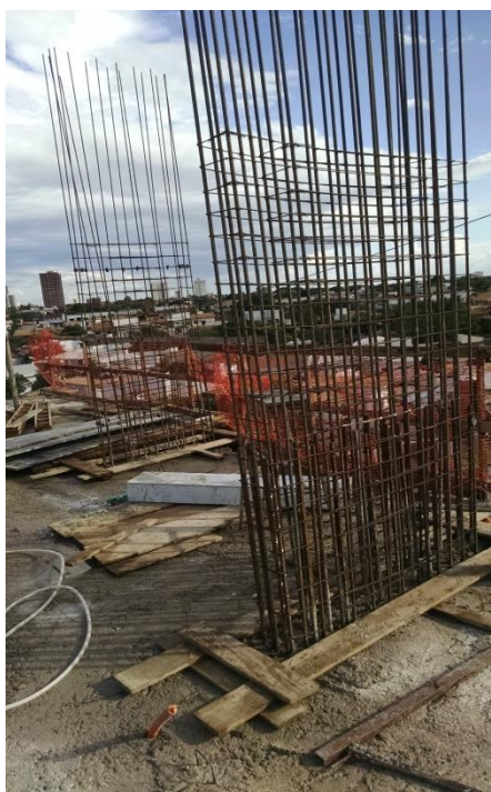
Figura 8 Armadura de pilar
