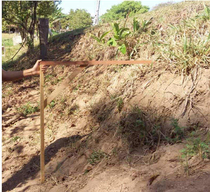
Figura 15 – Medição da altura de queda d'água
