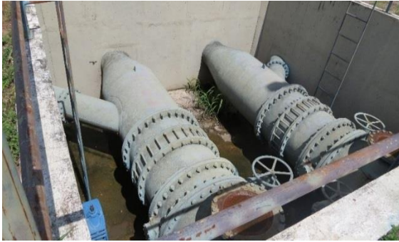
Figura 33- Linha de recalque Ø 1200mm
