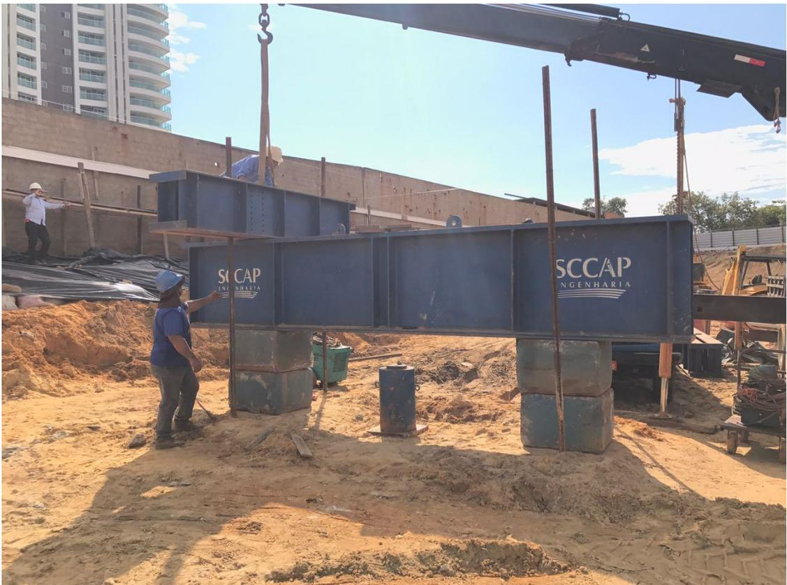
Figura 46 -Contenção de taludes adjacente ao local de execução das estacas e blocos
