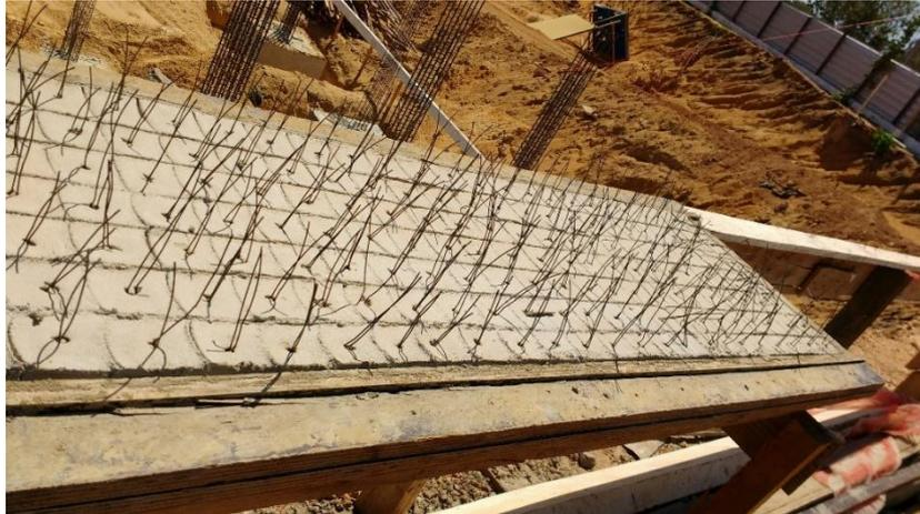
Figura 39- Armaduras das estacas confeccionadas
