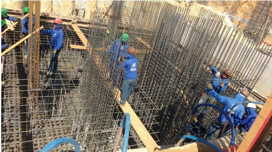
Figura 43- Concretagem do bloco de coroamento
