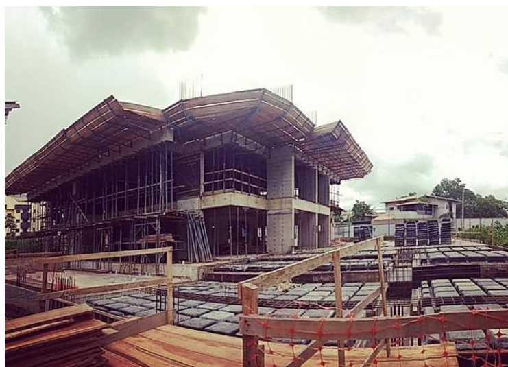
Figura 2 - Edifício em Concreto Armado.
