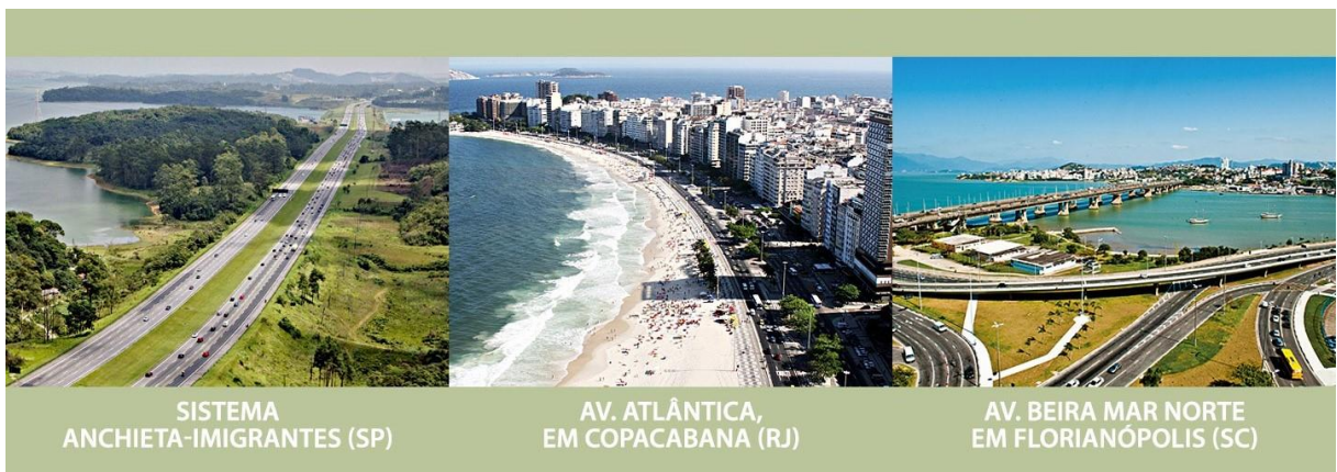
Figura 8: Vias com revestimento de Asfalto Borracha nas regiões sul e sudeste do país.
