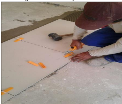
Figura 21 – Execução do nivelamento
