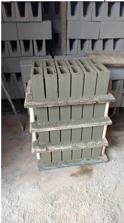
Figura 6 – Fabricação do bloco de concreto com adição de vermiculita expandida.
