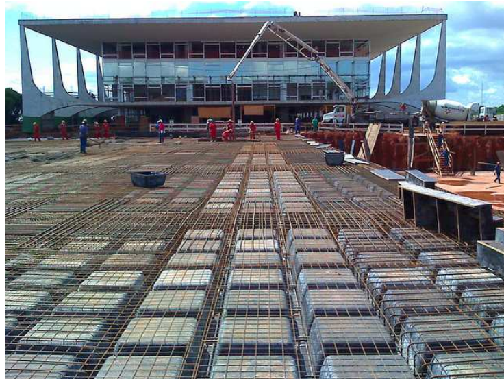
Figura 4: Lajes nervuradas com moldes plásticos
