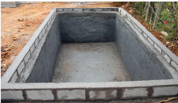
Figura 27 - Reservatório Enterrado
