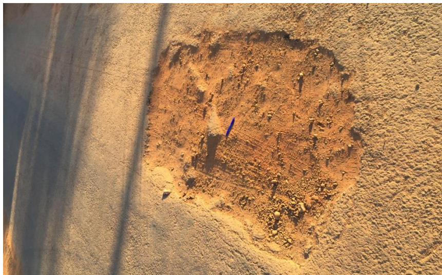
FIGURA 26 - Buraco/Panela.
