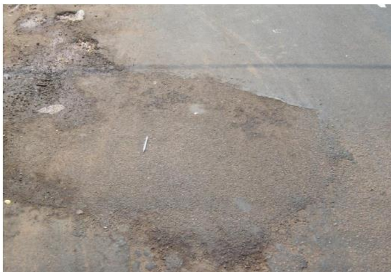
FIGURA 27 – Remendo
