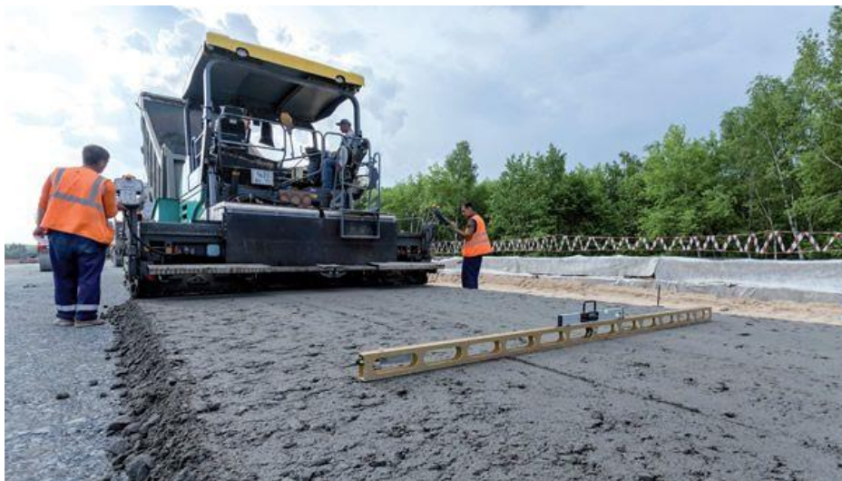
FIGURA 3 - Execução pavimento Semi-rígido
