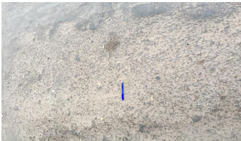
FIGURA 19 – Afundamento plástico localizado e desgaste.
