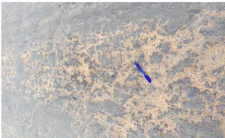
FIGURA 24 – Desgaste/ polimento.
