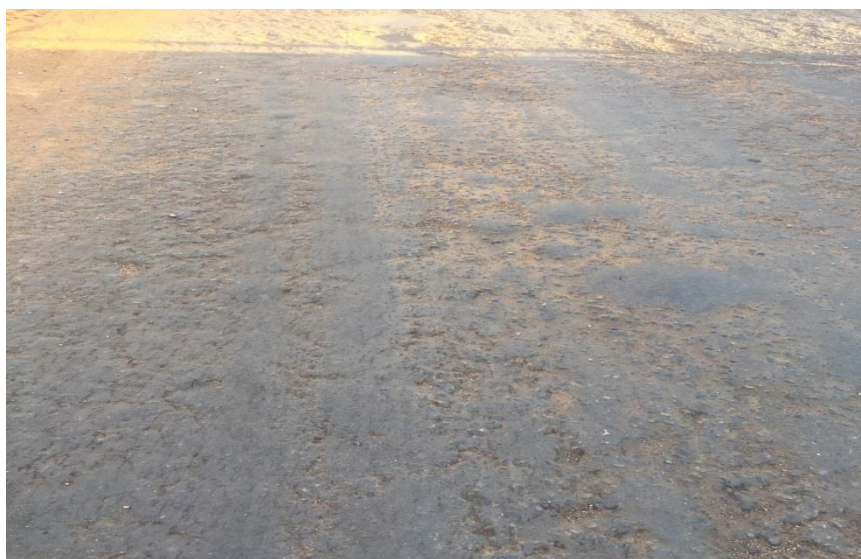
FIGURA 25 – Desgaste/ polimento
