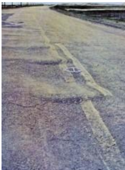
FIGURA 7 - Corrugação ou Ondulação
