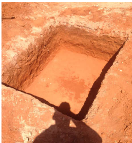
Figura 16 – Escavação do ponto de coleta
