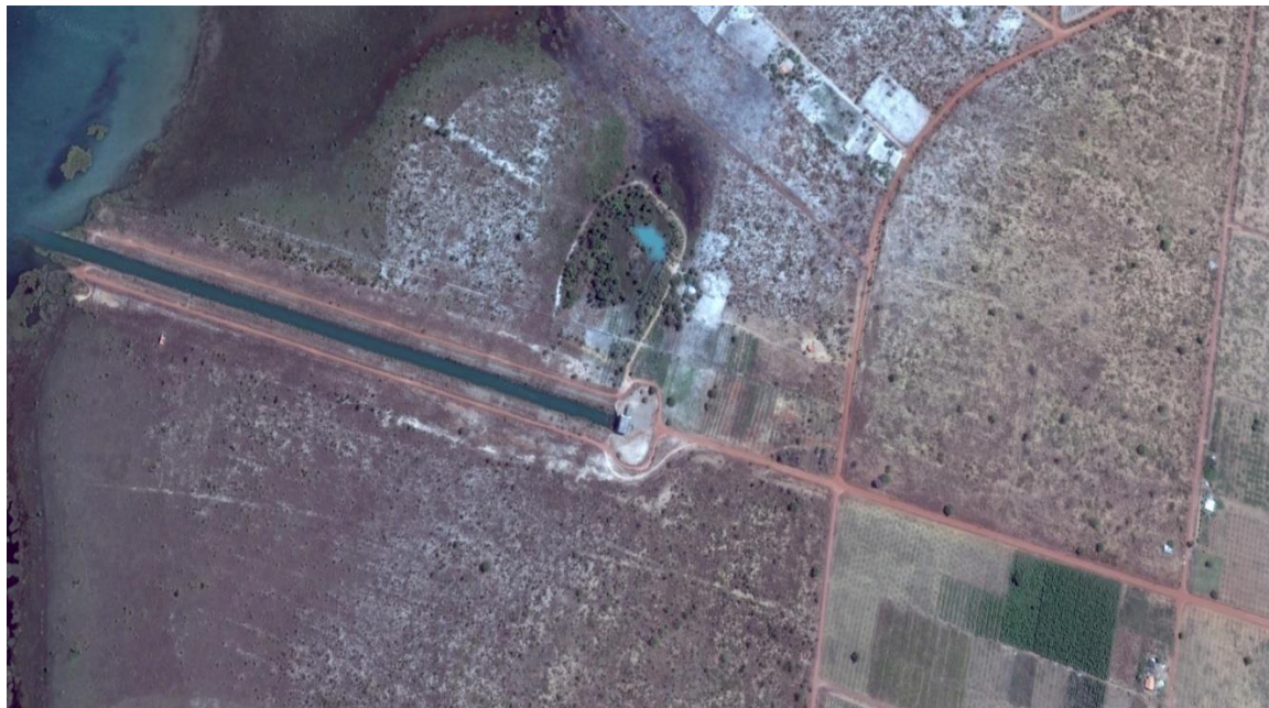
Figura 9 - Vista de satélite da estação de bombeamento 01 no município de porto nacional – TO
