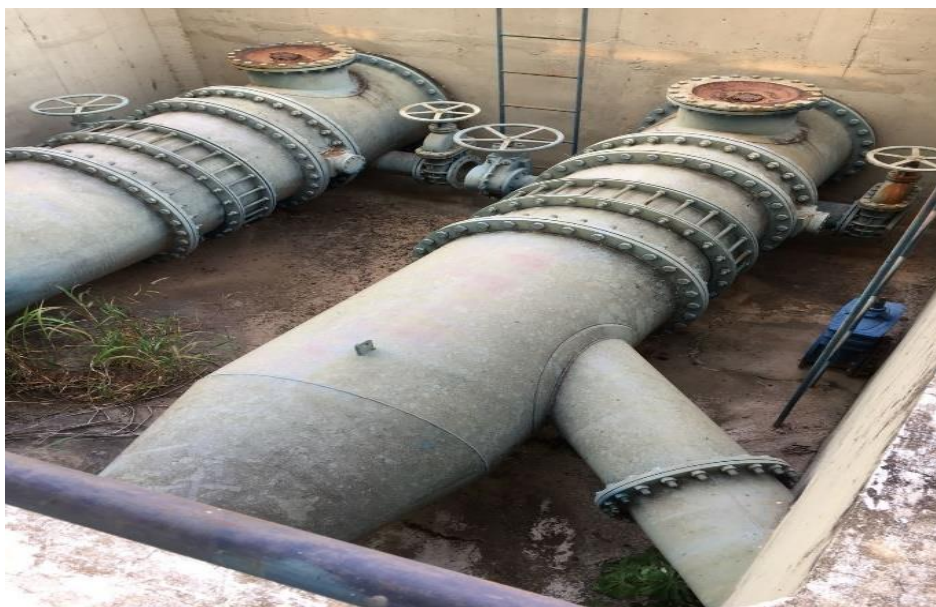
Figura 15 - Linha de Recalque 1200 mm e Peças Especiais
