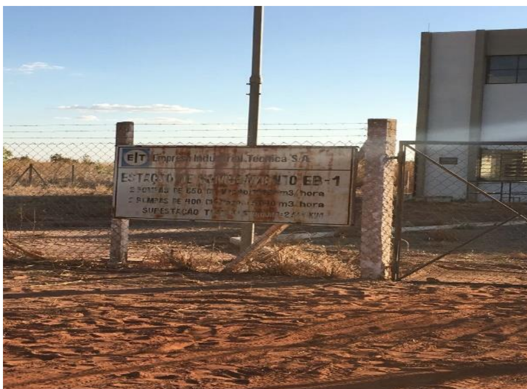
Figura 10 - Estação de Bombeamento – 001
