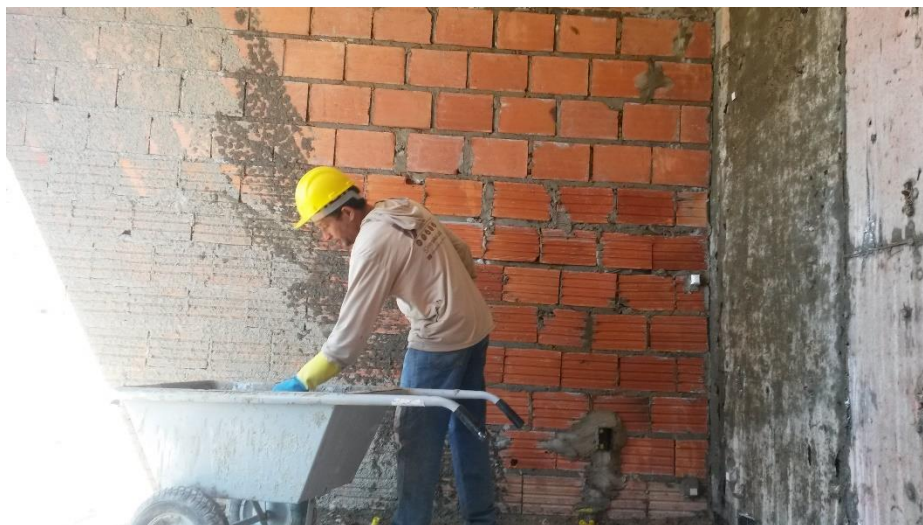
Figura 17: Superfície de aplicação do chapisco
