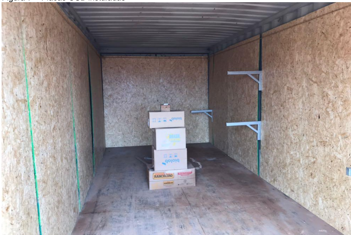
Figura 7 – Placas OSB instaladas
