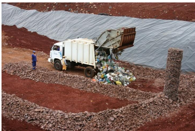
Figura 04 - Resíduos sendo descarregados na vala
