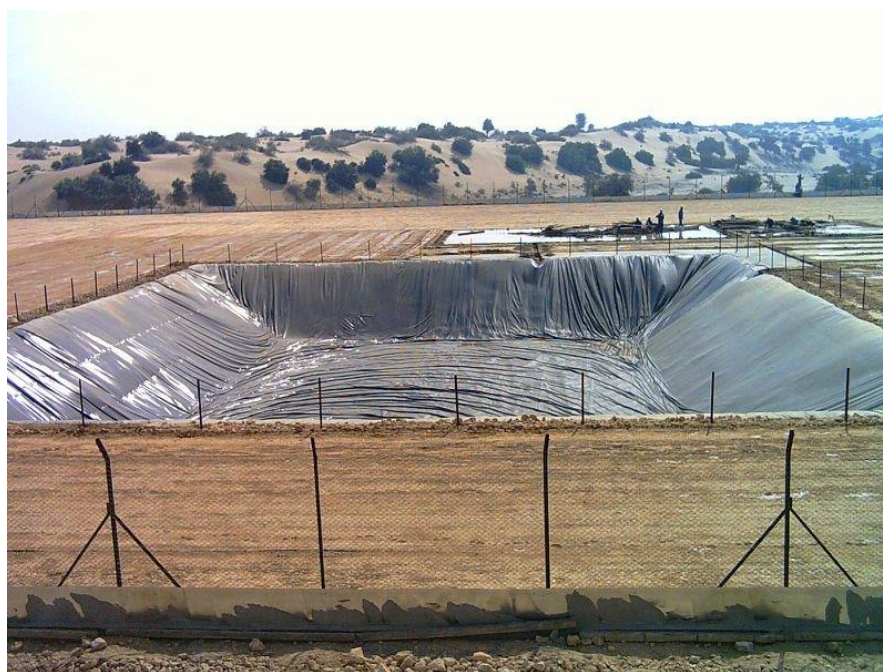
Figura 01 – Manta para impermeabilização
