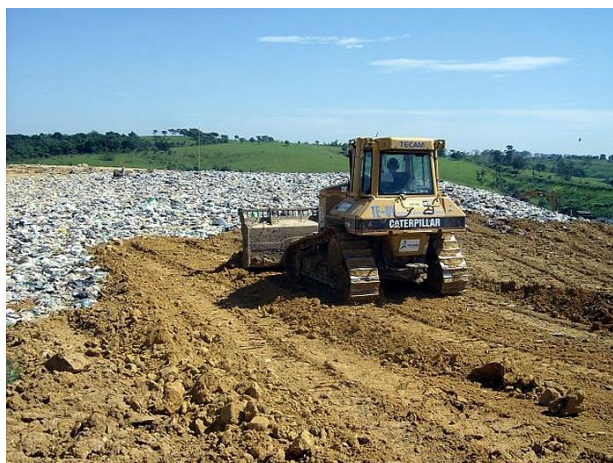
Figura 05 - Nivelamento e cobertura dos resíduos sendo realizados diariamente
