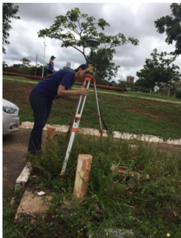
Figura 22- Anotações das bocas de lobo
