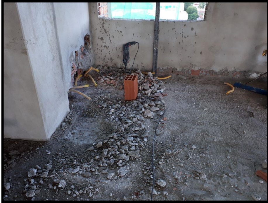
Figura 9 - Produção de resíduos sólidos de demolição por ocorrência da adaptação de projeto de telefonia e internet.
