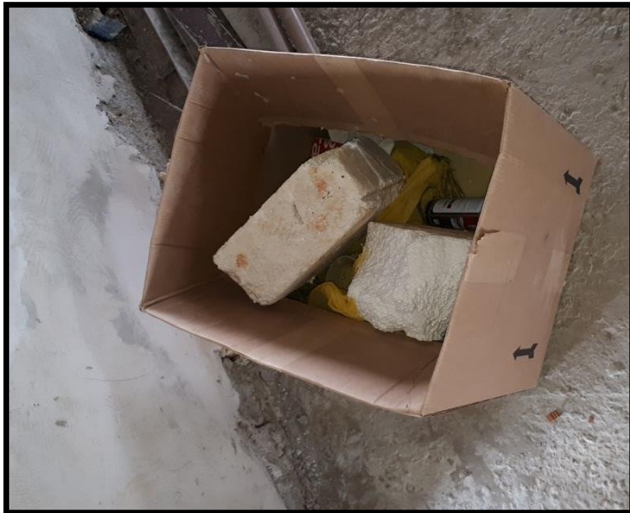
Figura 14 – Armazenamento temporário de resíduos sem segregação em recipiente sem sinalização.
