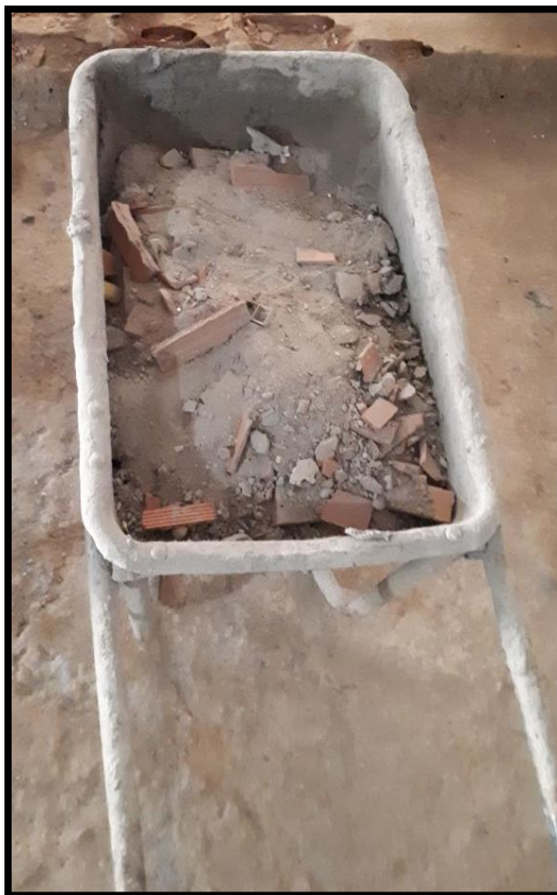
Figura 15 – Girica utilizada para transporte de resíduos.
