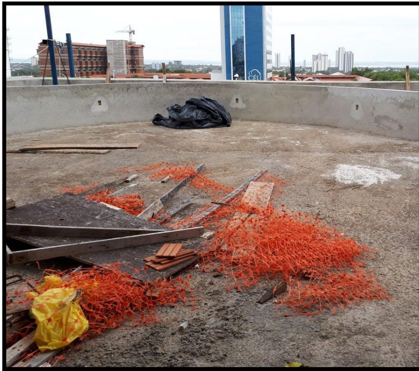
Figura 11 – Armazenamento temporário em locais inapropriados: Classe B e A (tijolo, madeira e plástico).
