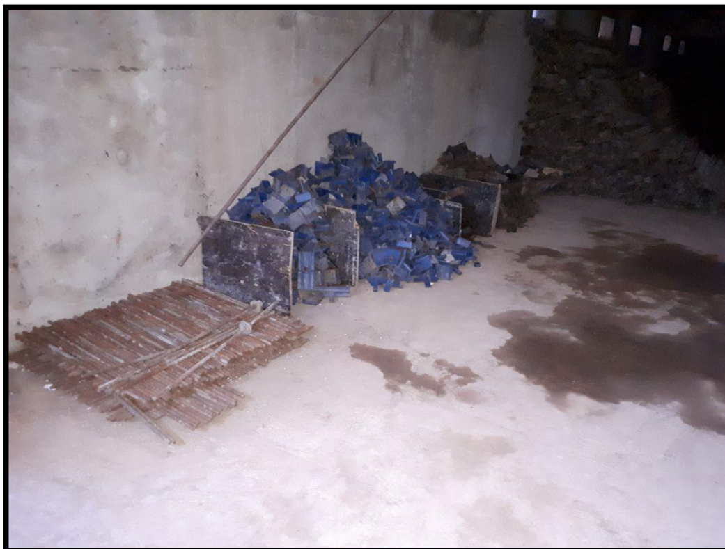
Figura 16 – Acondicionamento inadequado, sem sinalização e proteção.
