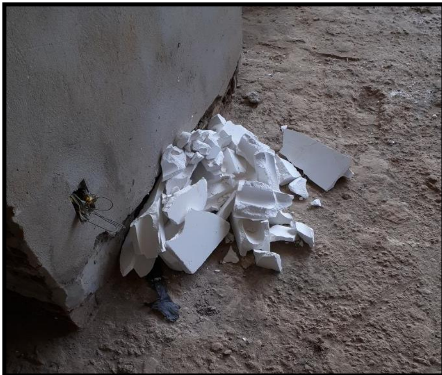
Figura 12 – Armazenamento temporário em locais inapropriados: Classe B (gesso).
