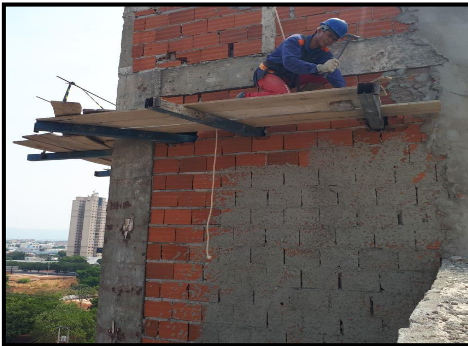
Figura 7 – Plataforma externa para serviço de chapisco e reboco.
