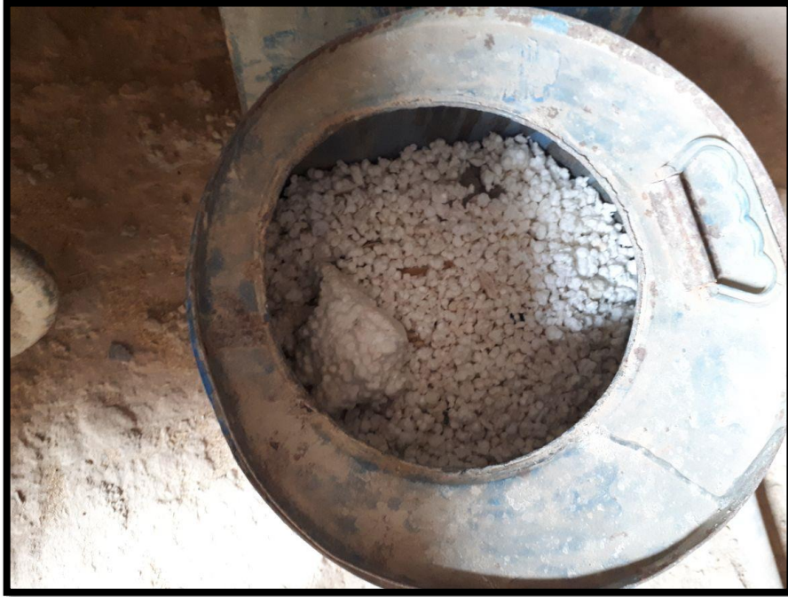
Figura 13 – Armazenamento temporário de EPS em tambor sem sinalização.
