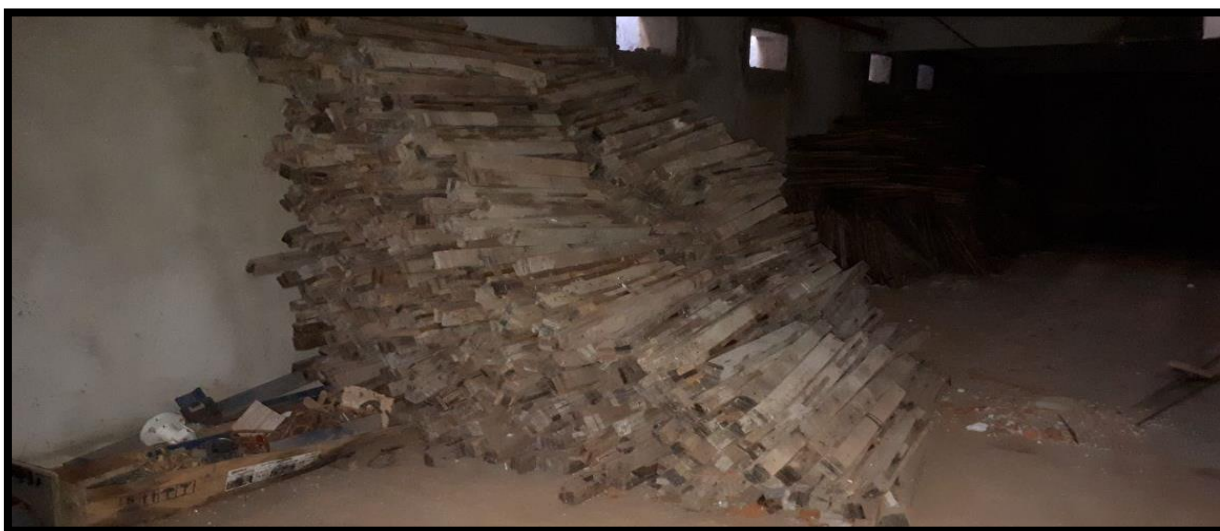
Figura 3 – Acondicionamento de madeiras de escora e formas.
