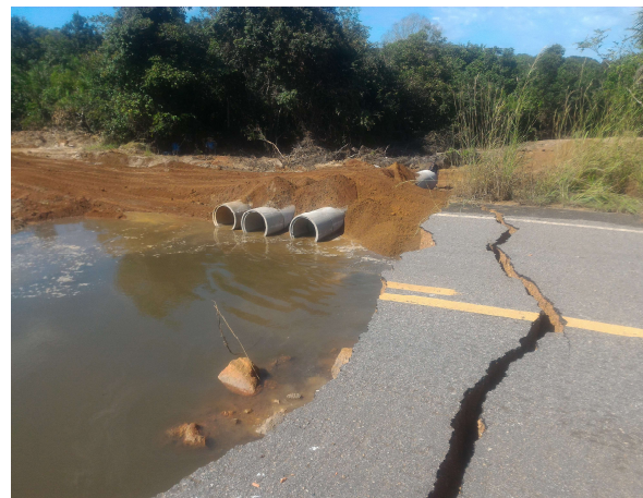
Figura 12: Canal para escoamento após evento.
