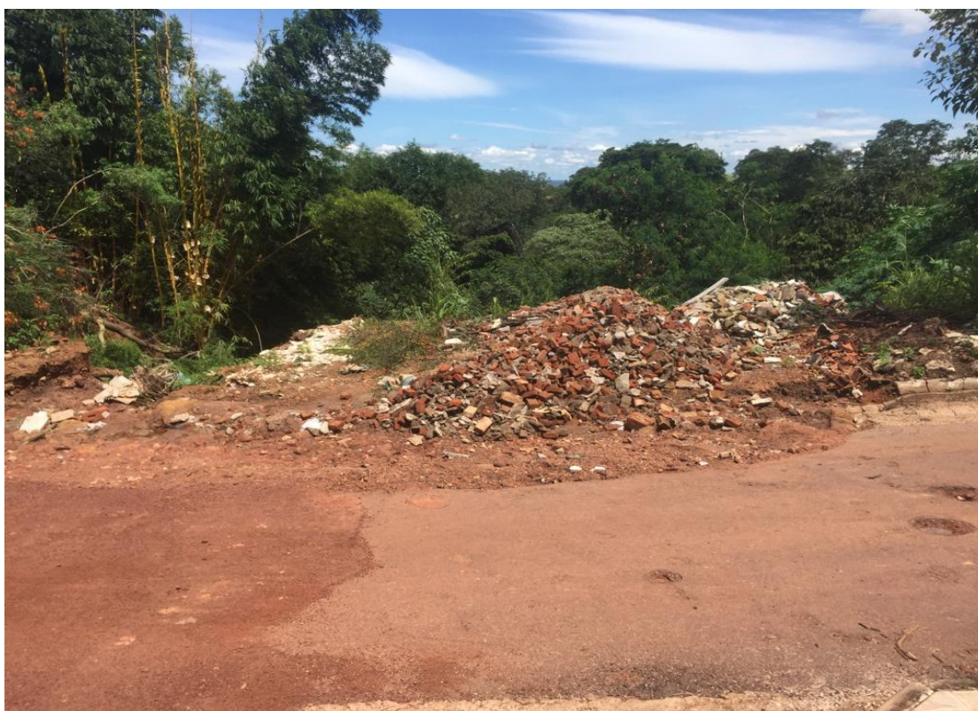
Figura 19. Preenchimento do local com entulho.
