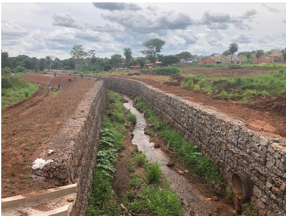
Figura 16. Gabião feito em Paraíso do Tocantins.
