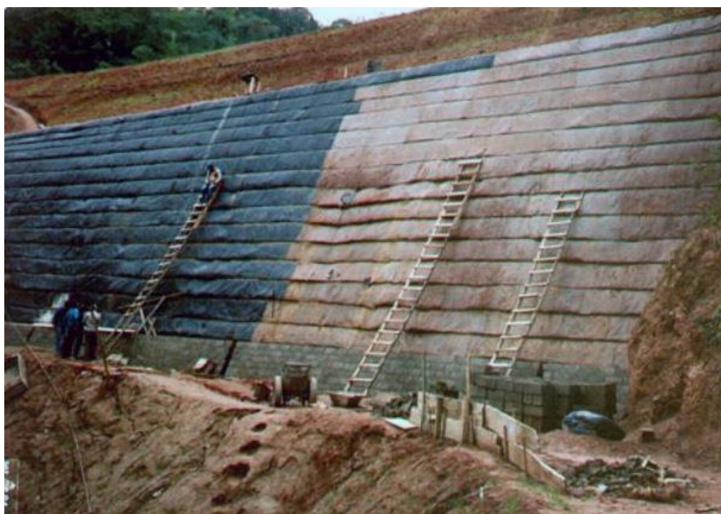
Figura 15. Uso de geotêxtil tecido e não-tecido na primeira obra de talude de solo reforçado no Brasil.
