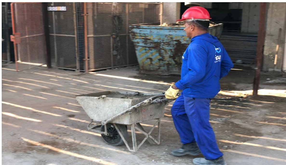
Figura 9: Argamassa é transportada para o elevador
