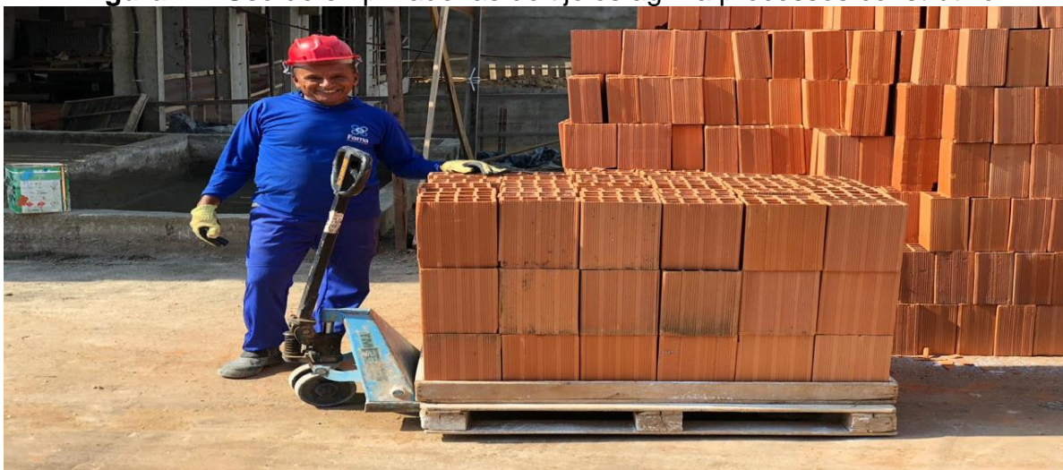
Figura 12: Uso de empilhadeiras de tijolos agiliza processos construtivo
