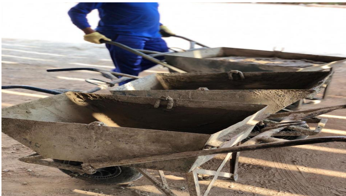
Figura 8: Transporte de Argamassa: o peso da carga deve ser suportado por um único trabalhador
