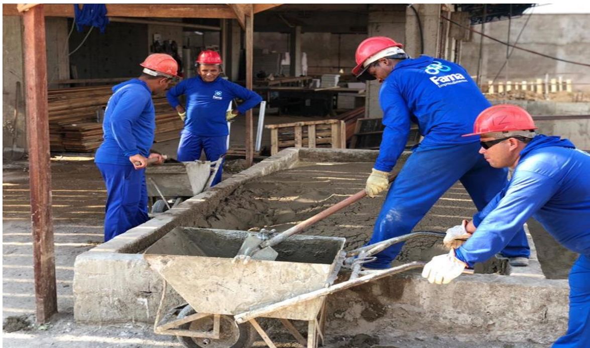
Figura 7: Distribuição da argamassa pronta nos carrinhos de mão
