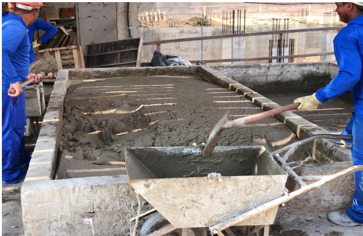
Figura 6: Entrega da massa pronta a ser usada na obra
