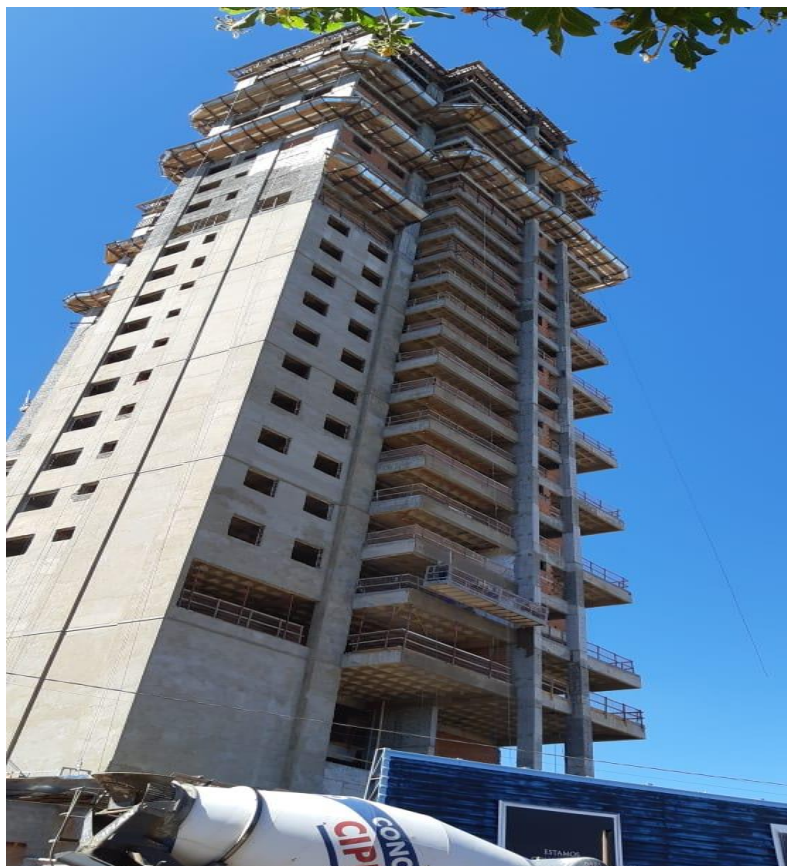
Figura 4: Fachada da edificação residencial vertical pesquisada. Palmas, TO
