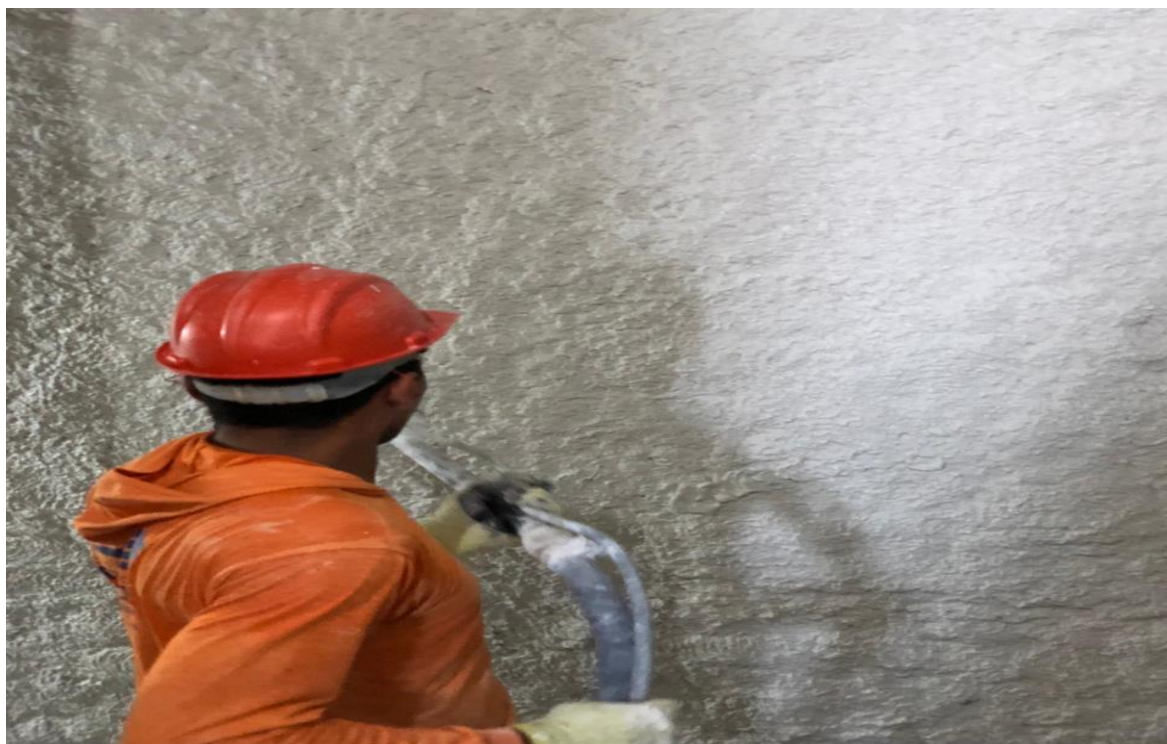
Figura 13: Aplicação de reboco: postura adequada evita riscos ergonômicos
