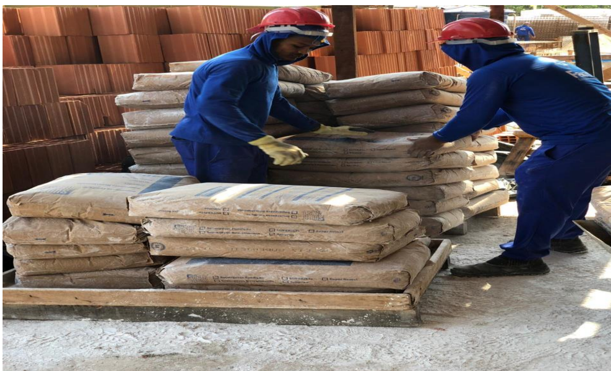
Figura 11: Sacos de cimento são armazenados em palates
