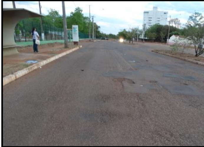
Figura 35 - Imagem de seguimento com muitas panelas e remendos
