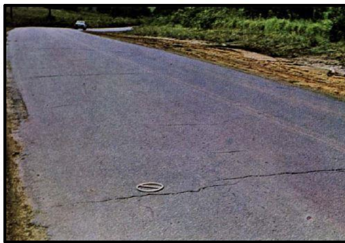
Figura 6 – Trinca transversal
