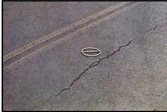
Figura 7 – Trinca longitudinal
