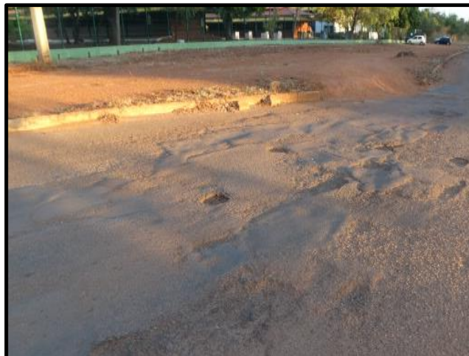
Figura 48 – Imagem de trecho crítico com grande quantidade de panelas desgaste e remendos
