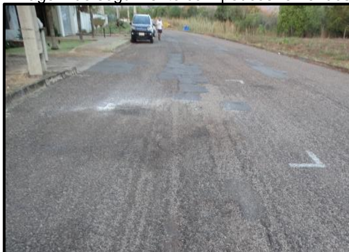
Figura 34- Imagem de seguimento com poucos remendos e desgaste
