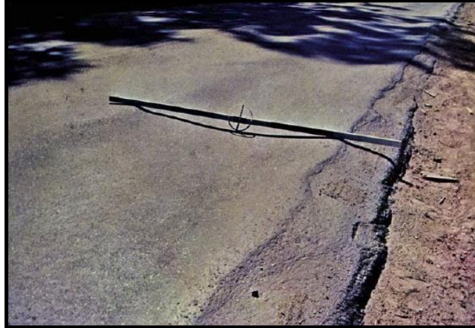
Figura 11 – Afundamento plástico nas trilhas de roda
