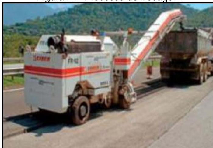
Figura 22- Processo de fresagem
