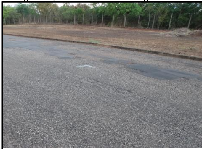
Figura 33- Imagem representativa com desgaste remendo e panela
