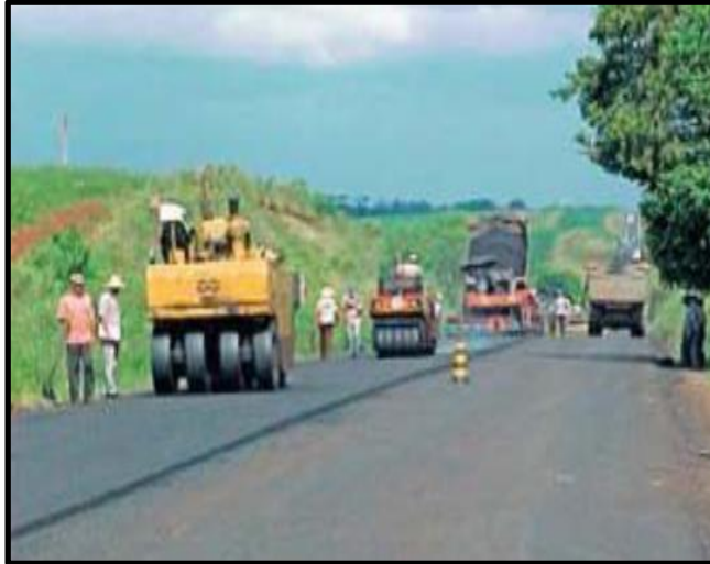
Figura 21 – Processo de recapeamento
