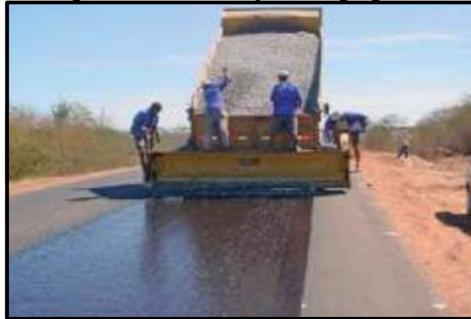
Figura 20 – Distribuição de agregado
