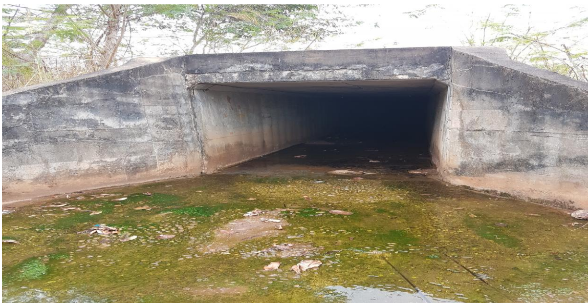
Figura 16 – Galeria pluvial
