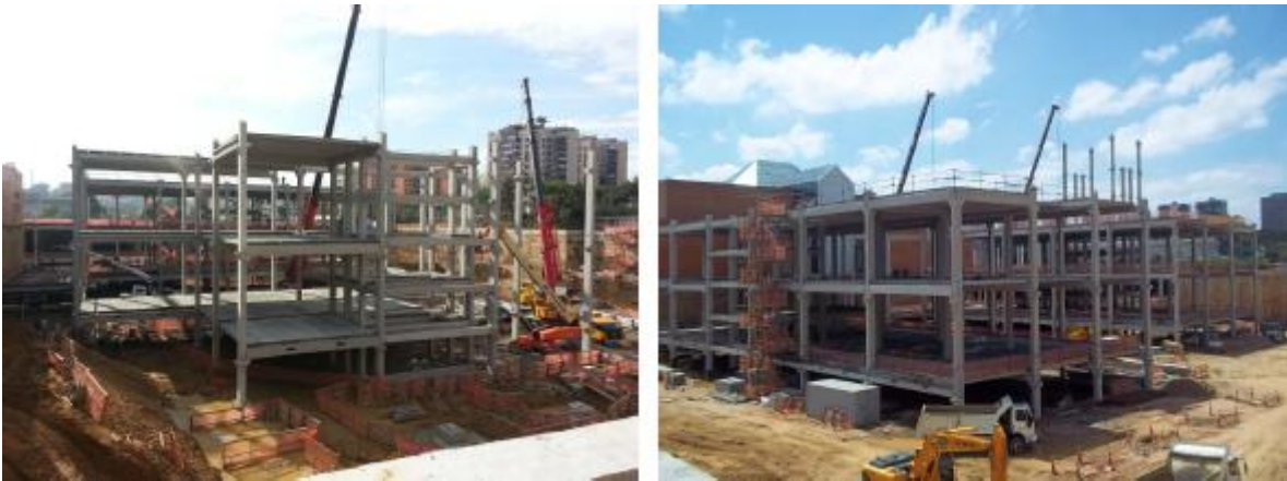
Figura 3 - Estrutura de shopping center em Porto Alegre - RS
