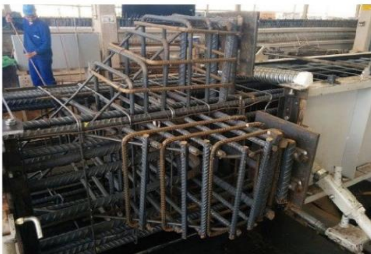
Figura 12 - Armadura posicionada em fôrma, com consolo executado com solda.
