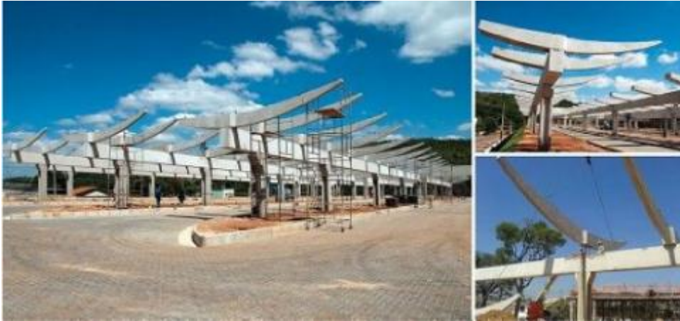
Figura 2 - Cobertura pré-moldada. Terminais rodoviários urbanos de integração BRT-BH.
