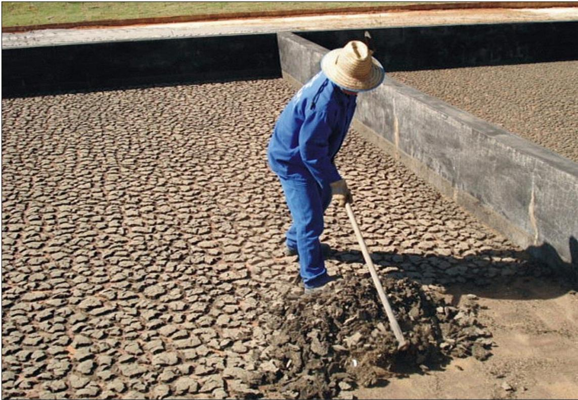
Figura 2: Lodo de Esgoto após o processo de Tratamento.
